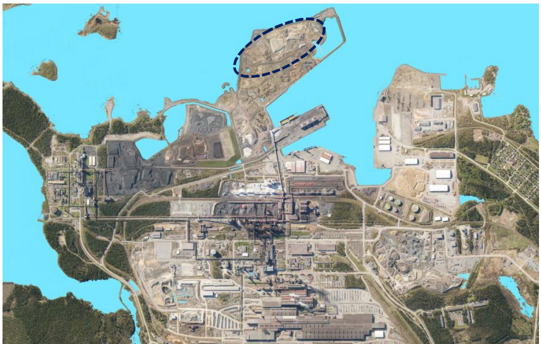
Kuva 2-2. Ilmakuva metallituotetehtaan alueesta SSAB:n ja Lapaluodon satamanonsan läheisyydessä. Hankealue on merkitty sinisellä katkoviivalla. (Valokuva: SSAB 2015)
