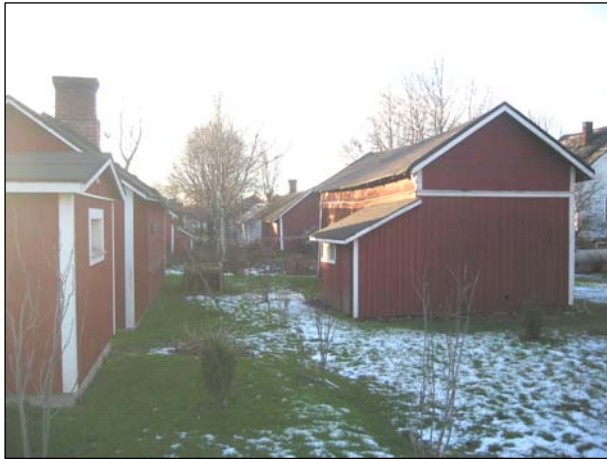
Korttelin sisäinen talousrakennusten muodostama kujanne.
