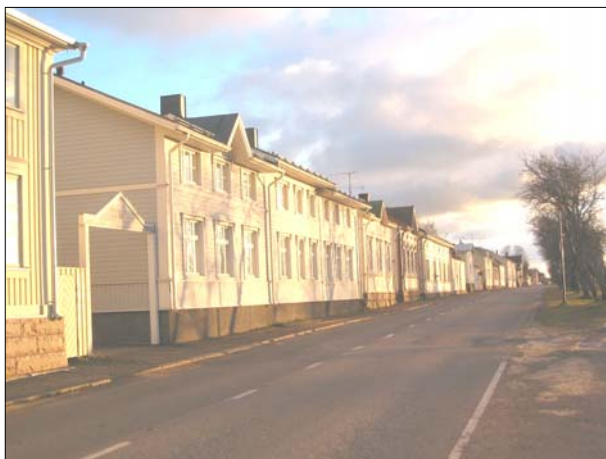
Rantakatu. Etualalla uutta ympäristöön sopeutuvaa rakentamista.
