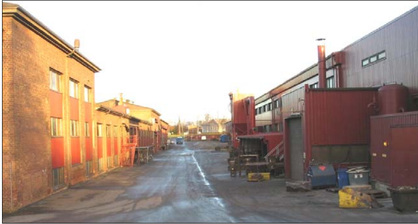
Vasemmalla Miilukangas Ky:n ja oikealla Keycast Oy:n teollisuus-rakennukset.
