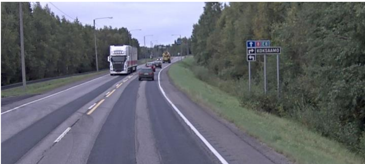
Kuva 7. Vt 8/ Koksaamontien nykyinen liittymäpaikka Raahen suunnalta.
