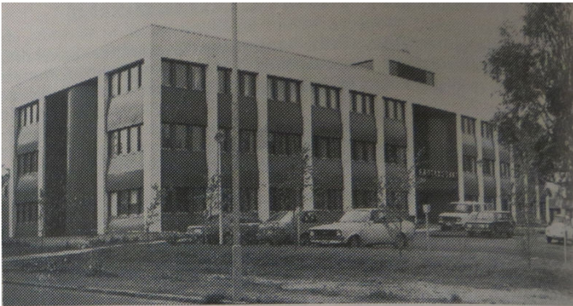
Kaupunkikonttori vuonna 1981. Kaupunkikonttorin ulkoseinät ovat yhtiön muovipinnoitettua ohutlevyä.
