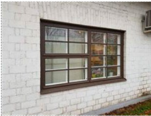
Piirteiltään vaatimattomassa rakennuksessa omaleimaisina yksityiskohtina erottuvat vaihteleva tiililimitys ja siropuitteiset ikkunat. (Kuva: Kaisa Mäkinie mi 2018)
