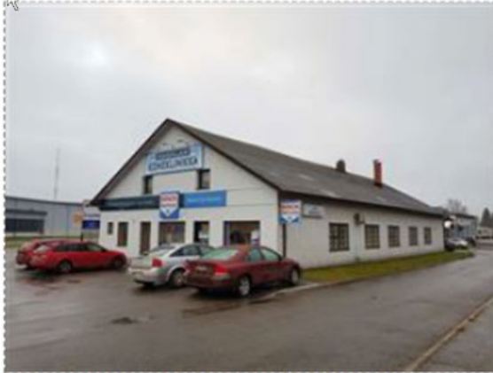
Idän puoleinen pääty ja julkisivu Ouluntielle. (Kuva: Kaisa Mäkinie mi 2018)
