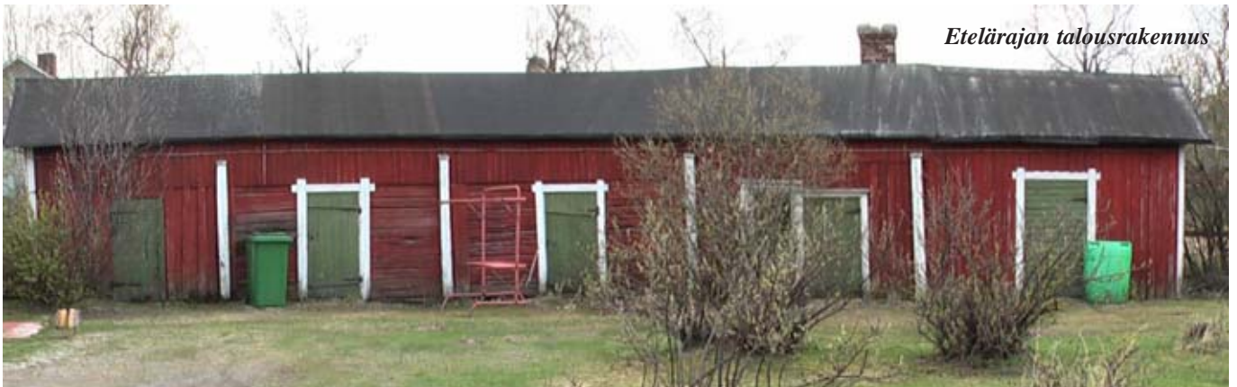
Takasivu etelään palosolalle päin
