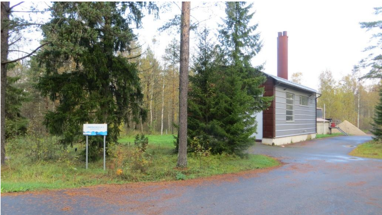
Raahen Energia Oy:n lämpövoimala sijaitsee Antinkankaan koulualueen vieressä, Isoholmintien toisella puolen.
