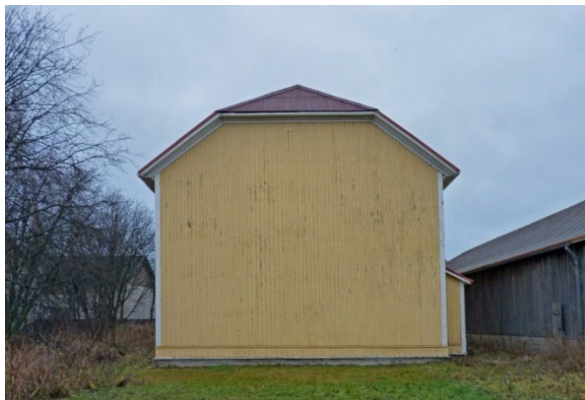
Bio Huvimyllyn sisäpihan puoleinen julkisivu.
