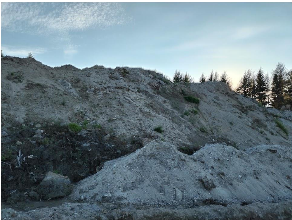
Kuva 12 Rakennustyömaan maakasoissa ei ollut merkkejä törmäpääskyn pesäkoloista. Teppo Mutanen 2024.
