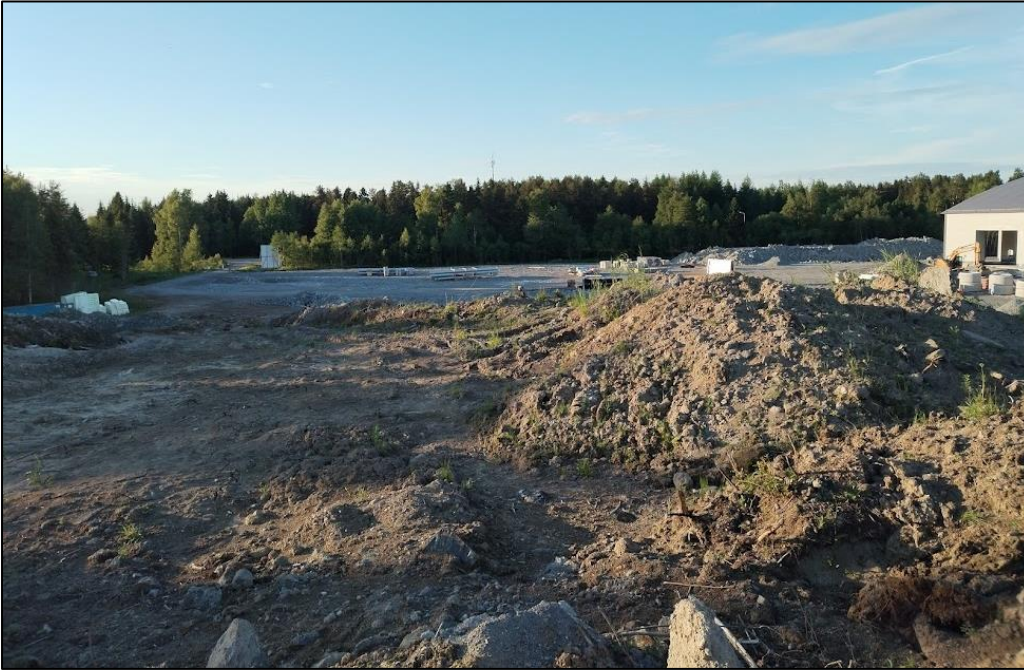
Kuva 2 Yleisnäkymää alueen rakenteilla olevista osista. Teppo Mutanen 2024.
