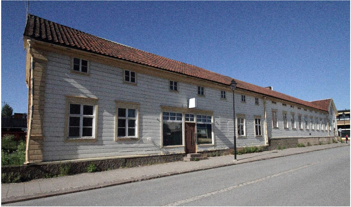
Kuva 4. Friemanin talon liiketilat Koulukadun varrella rakennuksen länsipäässä. Liiketilojen kivijalka on muuta rakennusta matalampi ja ullakkokerros korkeampi räystääslinjan ollessa kuitenkin yhtenäinen. Liiketilojen keskellä on kaksi isoa näyteikkunaa, joiden välissä on ovi liiketiloihin. Liiketilassa on viimeksi toiminut huolintayritys. Rakennuksen ulkonäköä on kuvailtu edellä luvussa "Rakennuksen kuvaus".
