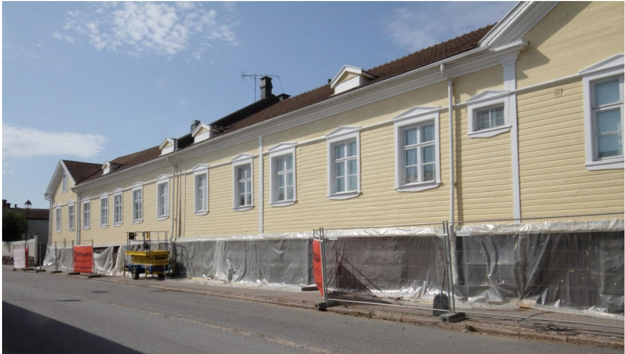
Kuva 2. Kohteen päärakennuksen Koulukadun puoleista julkisivua oltiin kunnostamasta inventointia tehtäessä kesällä 2020. Julkisivuvuoraus on puhdistettu ja kunnostettu sekä maalattu kesällä 2020. Kivijalkaa peittää kuvassa suojamuovit. Rakennuksen ulkonäköä on kuvailtu edellä luvussa ”Rakennuksen kuvaus”.
