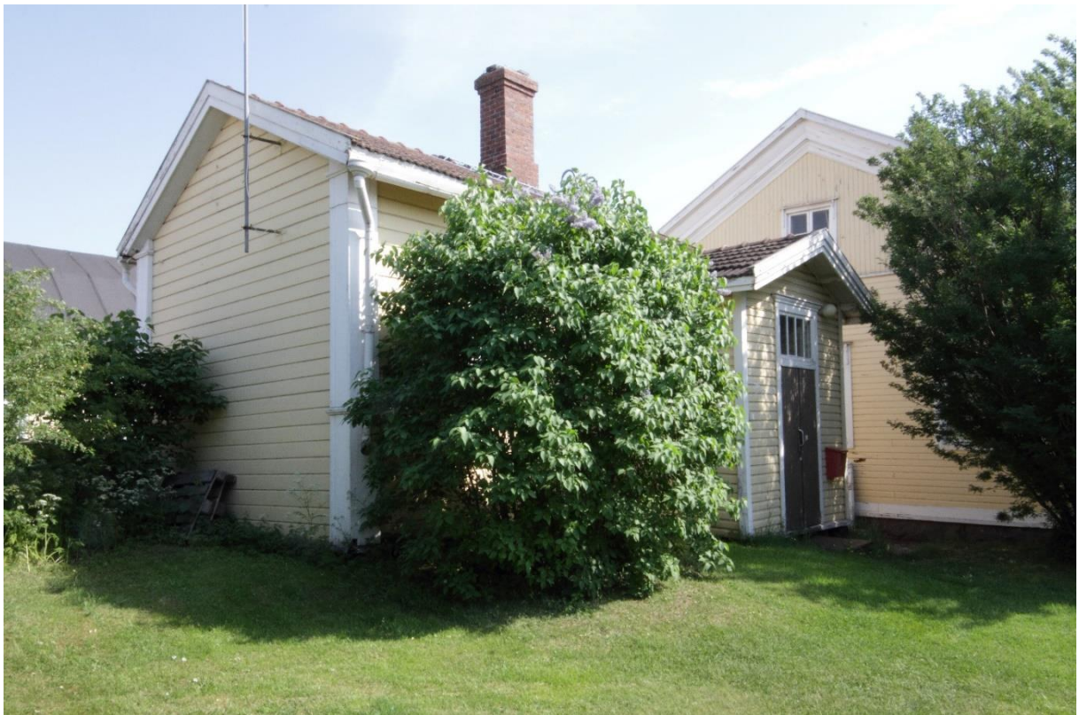
Kuva 7. Portinvartijan talon pihajulkisivulla kasvaa syreenipensas. Pihan puolella on myös harjakattoinen umpikuisti. Portinvartijan talon takana kuvassa näkyy päärakennuksen Kauppakadun puoleisen siiven pohjoispääty. Piha on nurmella portinvartijan talon ympärillä. Rakennuksen ulkonäköä on kuvailtu edellä luvussa "Rakennuksen kuvaus".
