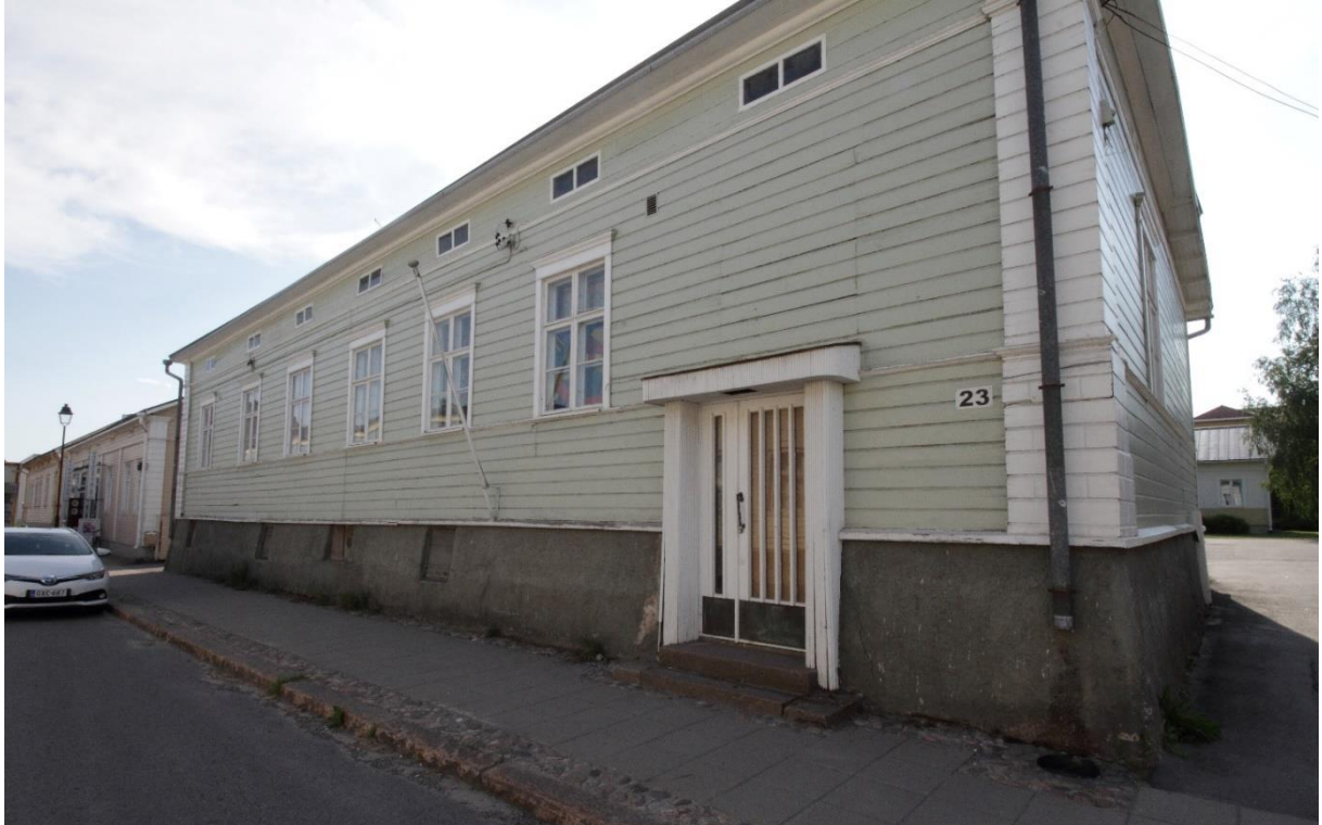
Kuva 2. Kohteen päärakennuksen Kirkkokadun puoleinen julkisivu. Kuvan oikeassa reunassa näkyy ovi rakennuksessa olleisiin liiketiloihin. Rakennuksen ulkonäköä on kuvailtu edellä luvussa "Rakennuksen kuvaus".
