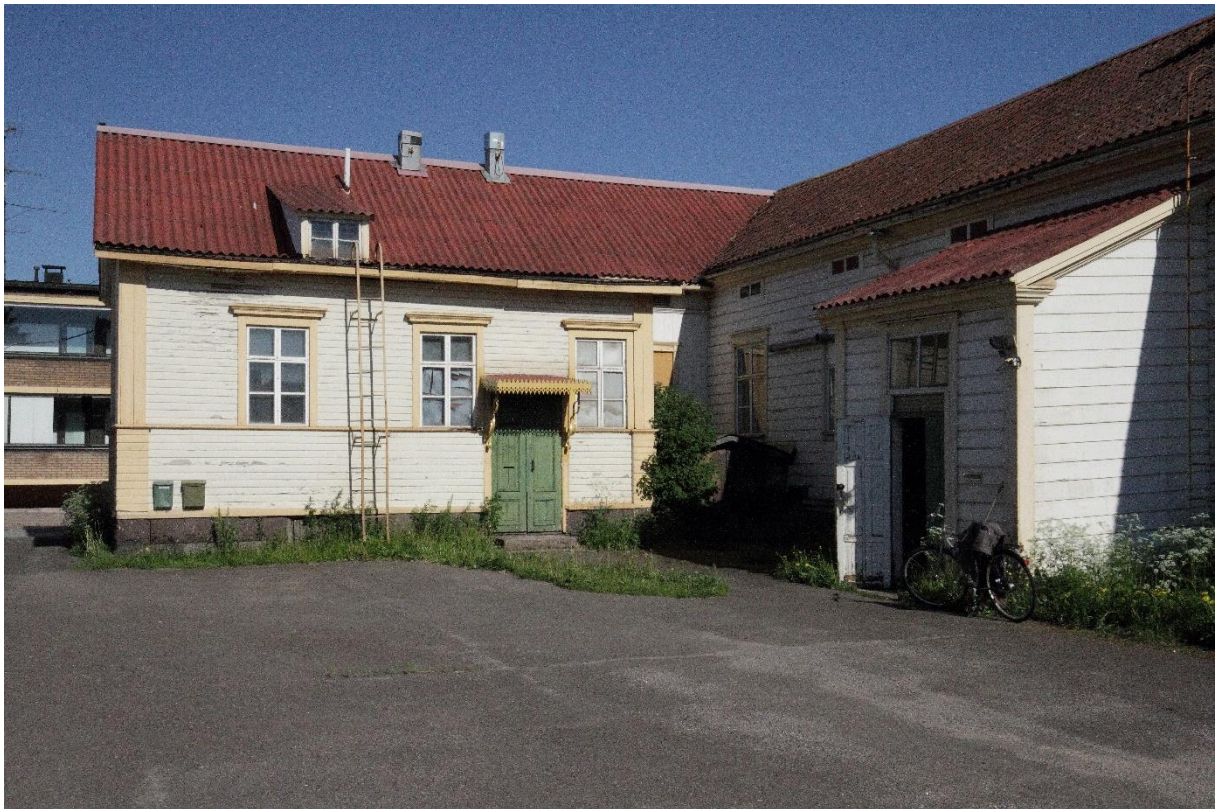
Kuva 5. Friemanin talon Kirkkokadun puoleisessa siivessä on iso lapekattoinen umpikuisti ja vanha pariovi. Pihan puolella siiven vesikatteenä on aaltopelti. Kauppakadun puoleisen siiven kuisti on pienempi lapekattoinen umpikuisti. Myös siinä on vanha pariovi. Kellarin sisäänkäynti sijaitsee rakennuksen kulmassa. Piha on lähes kauttaaltaan asfaltoitu. Rakennuksen ulkonäköä on kuvailtu edellä luvussa "Rakennuksen kuvaus".
