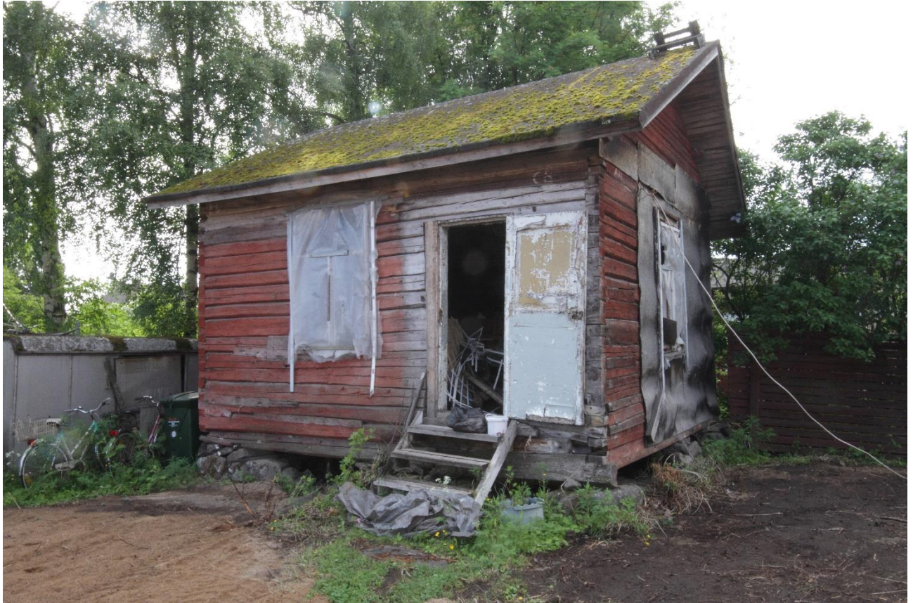
Kuva 4. Kohteessa olevan talousrakennuksen pihan puoleinen pohjoisjulkisivu. Rakennuksen pohjoisjulkisivulla on ovi, jonka kohdalla on ilmeisesti joskus ollut kuisti. Rakennuksen ulkonäköä on kuvailtu edellä luvussa "Rakennuksen kuvaus".
