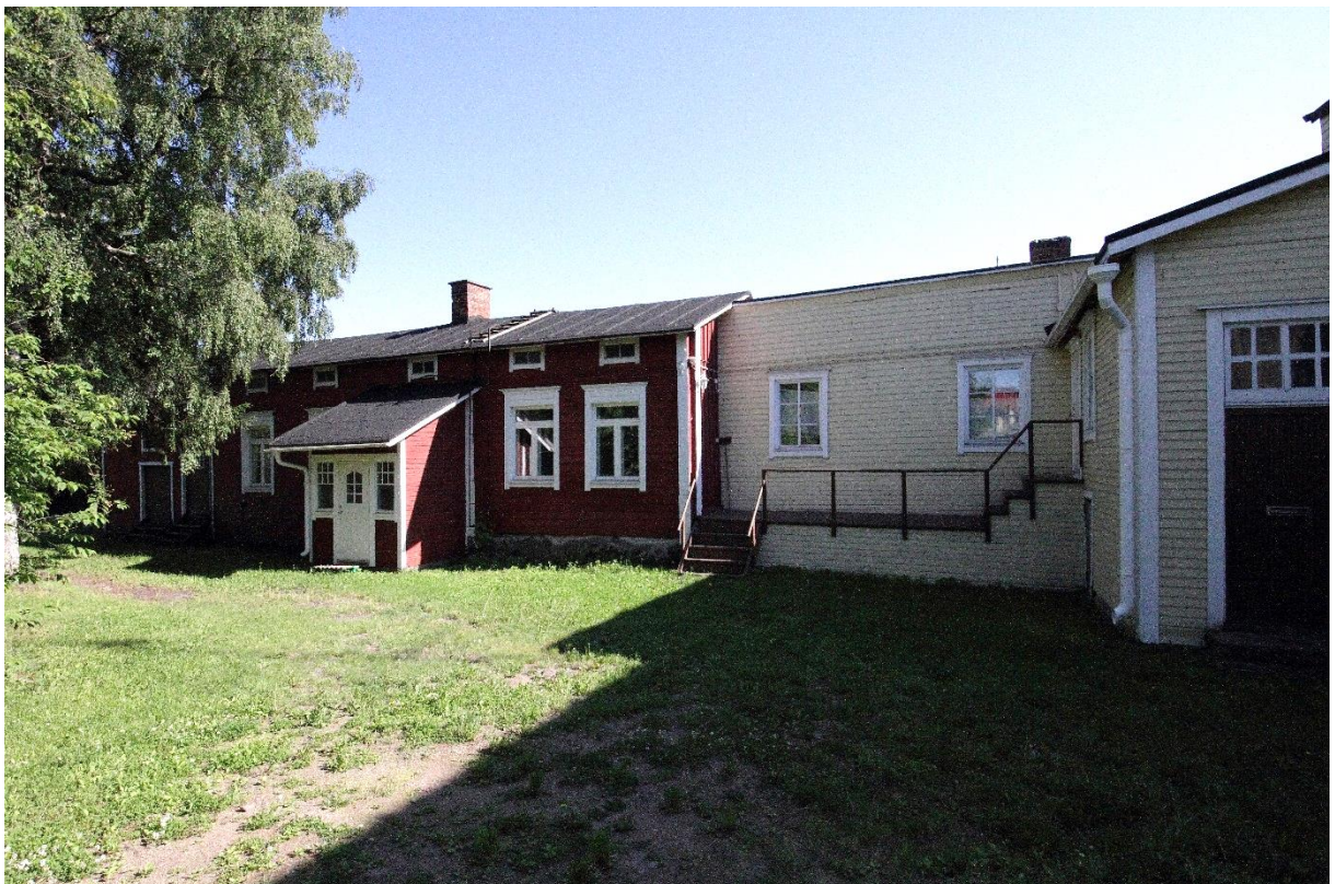
Kuva 4. Siipirakennuksen keskellä on asuinrakennus. Sen liittyy päärakennukseen lapekattoinen rakennusosa, jossa on säilynyt vanhat 6-ruutuiset ikkunat. Asuinrakennuksen itäpäädyssä on 2 kerroksinen aitta. Piha on nurmikolla ja keskellä pihaa kasvaa iso koivu. Rakennuksen ulkonäköä on kuvailtu edellä luvussa "Rakennuksen kuvaus".
