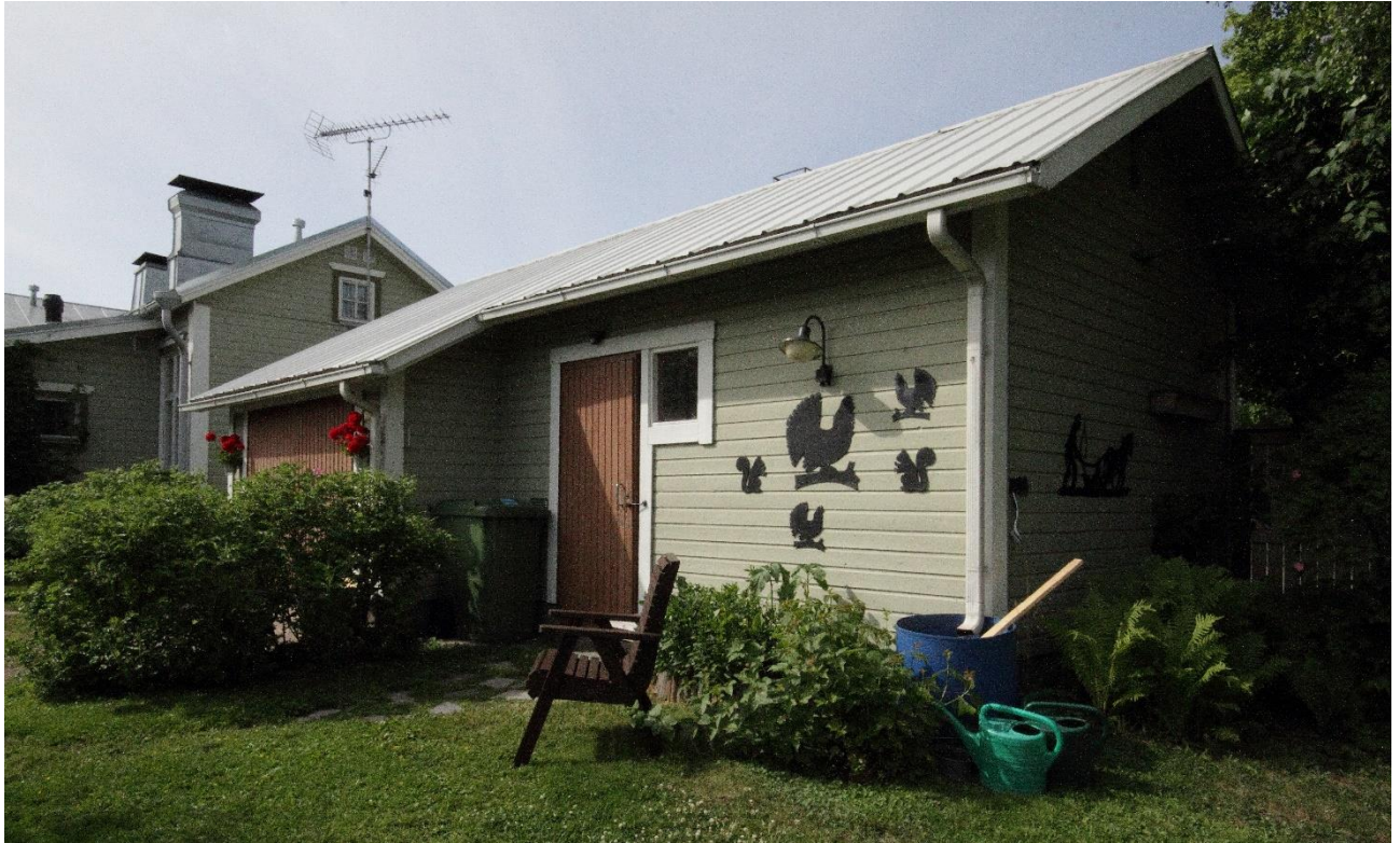
Kuva 4 Tontin pohjoislaidalla on autotallin ja puuvajan käsittävä talousrakennus. Rakennuksen ulkonäköä on kuvailtu edellä luvussa "Rakennuksen kuvaus".
