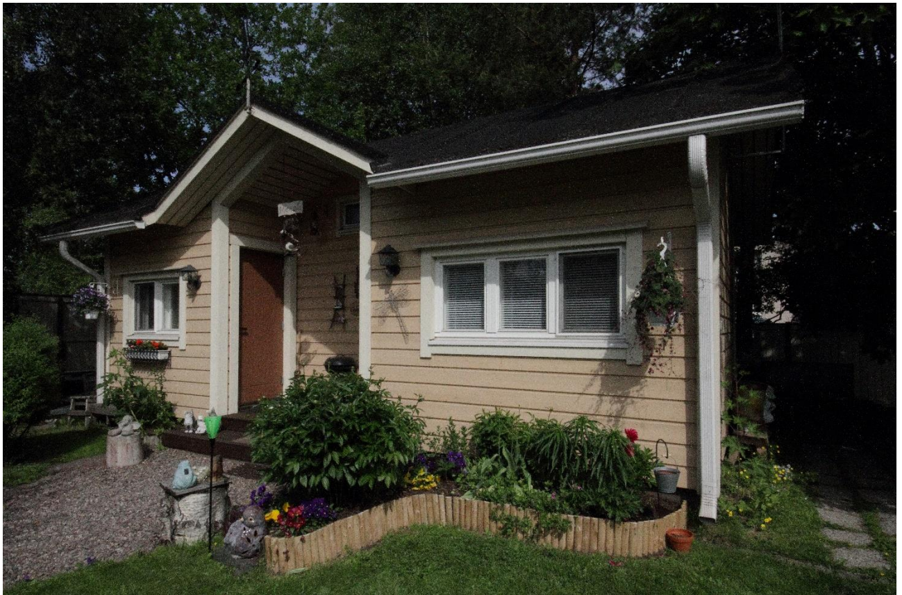
Kuva 5 Tontin perällä on 2000-luvun vaihteesta oleva talousrakennus. Rakennuksen ulkonäköä on kuvailtu edellä luvussa "Rakennuksen kuvaus".
