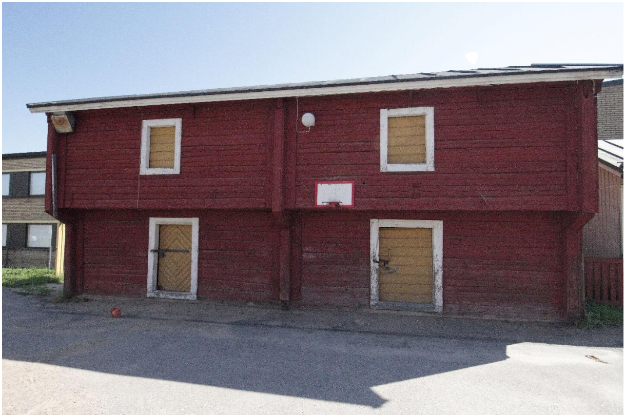
Kuva 5. Päiväkodin sisäpihaa rajaa etelästä kaksihuoneinen kaksikerroksinen otsallinen riviaitta. Rakennuksen ulkonäköä on kuvailtu edellä luvussa ”Rakennuksen kuvaus”.
