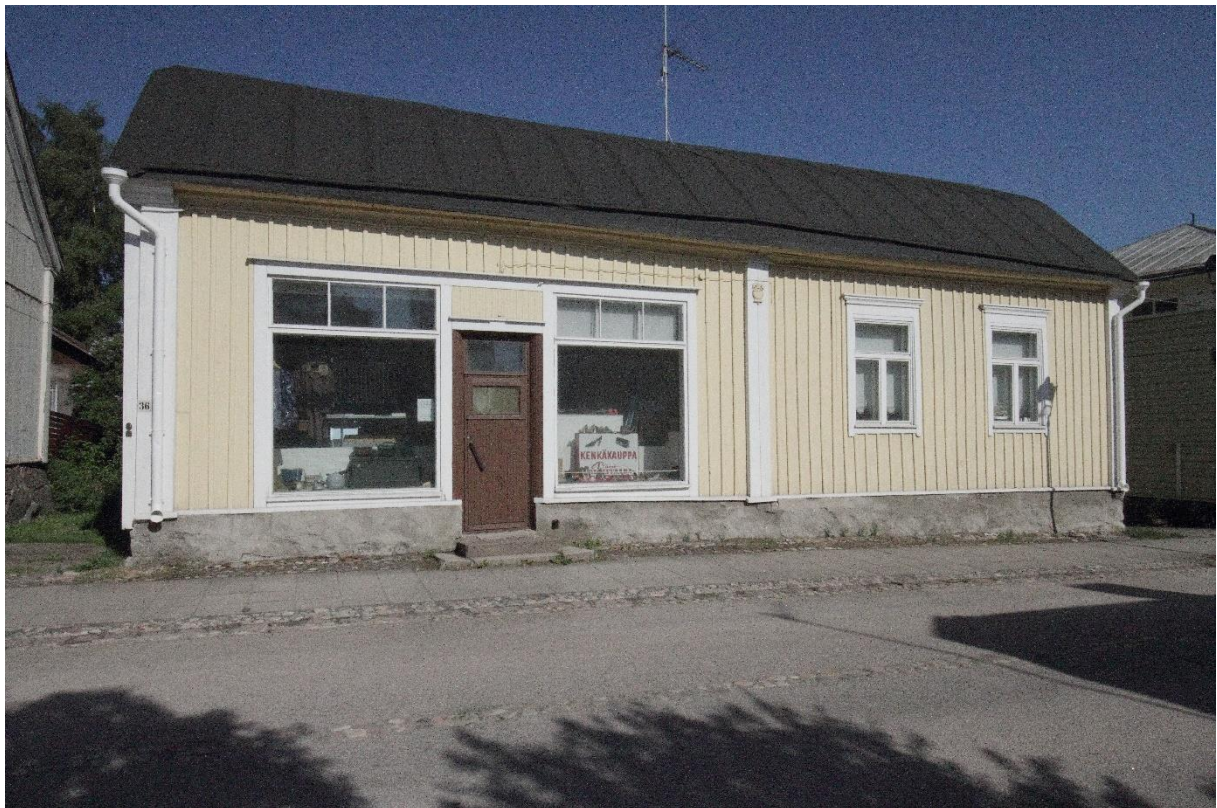
Kuva 2. Päärakennuksen katujulkisivua luonnehtii liiketilan isot näyteikkunat ja niiden välissä oleva ovi. Rakennuksen ja naapuritalojen välissä on vain kapeat pihaille johtavat aukot. Talojen välissä olleet portit on purettu 1900-luvun loppupuoliskolla. Rakennuksen ulkonäköä on kuvailtu edellä luvussa "Rakennuksen kuvaus".
