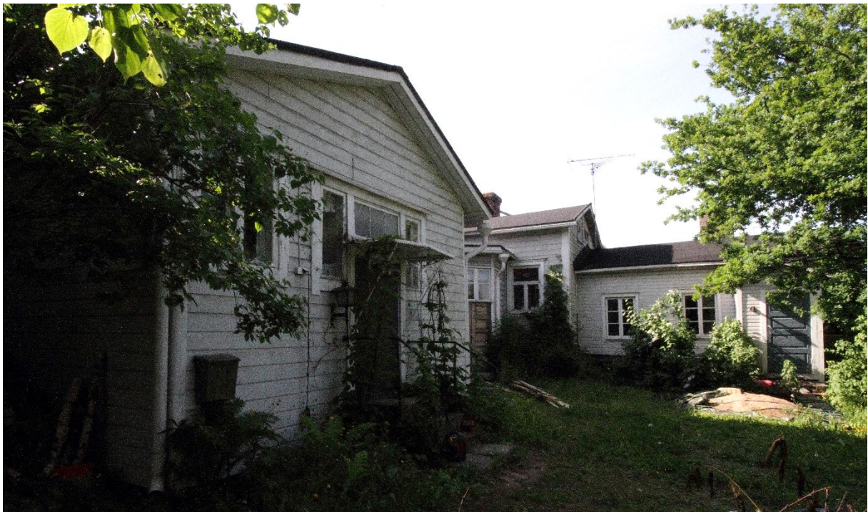
Kuva 3. Kohteen asuinrakennuksen pihajulkisivu koostuu useista eri rakennusosista ja polveilee moniulotteisesti. Kuvan vasemmassa reunassa näkyy rakennuksen eteläosan laajennus, josta on sisäänkäynti rakennukseen. Kuvan keskellä näkyy pohjoisemman rakennusosan pihasiipeä ja sen kulmassa olevaa mutterikuistia. Kuvan oikeassa laidassa näkyy
