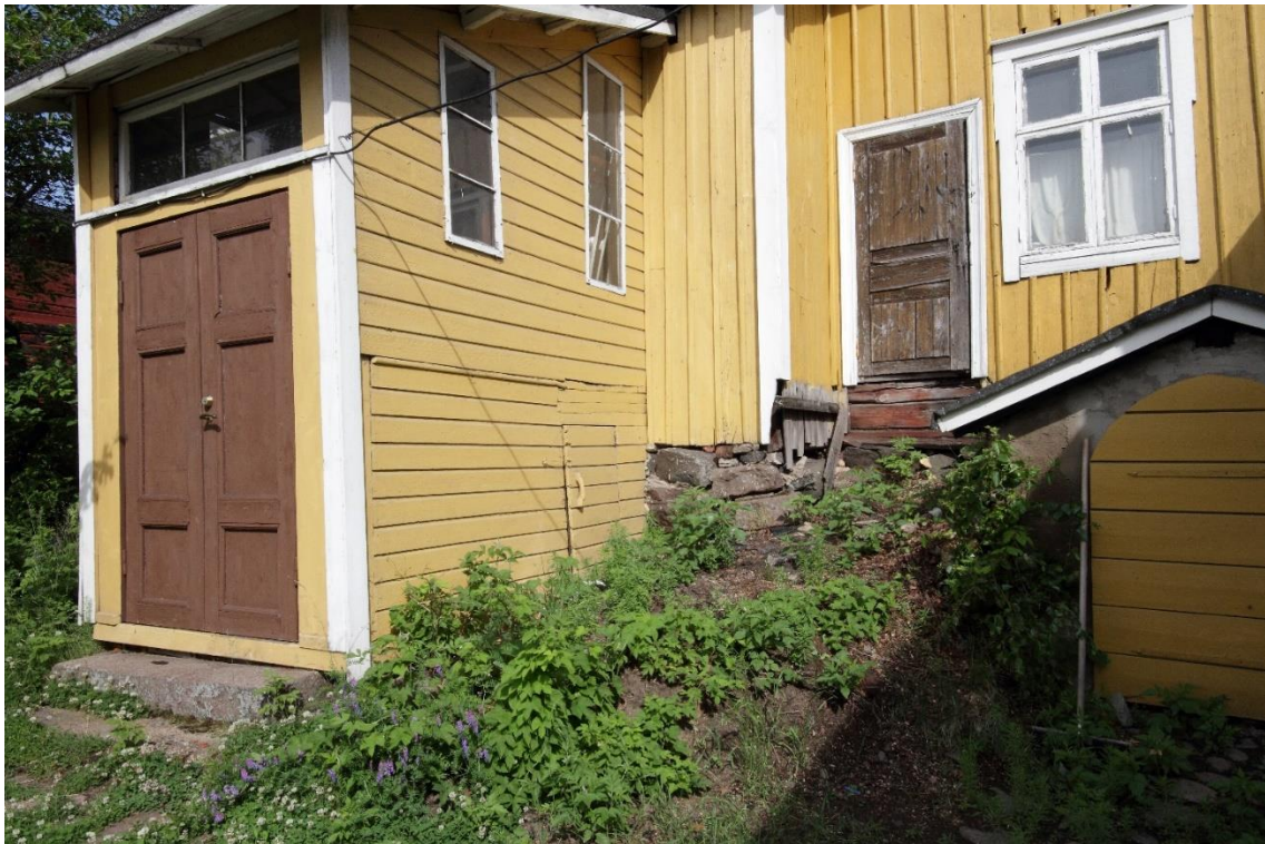
Kuva 4. Kuvassa näkyy entisen pakarirakennuksen umpikuisti ja kuistin vanha pariovi. Ovi on yksinkertainen, ruskeaksi maalattu peiliovi. Kuvan oikeassa reunassa näkyy pakarin asuintaloon yhdistävä laajennus, joka on runkosyvyydeltään hieman kapeampi kuin pakari. Laajennusosan ovi on peiliovi eikä se enää ole käytössä. Ovelle johtaneet portaat on purettu pois. Kuvan oikeassa alareunassa näkyy laajennusosan alla olevan kellarin sisäänkäynti. Rakennuksen ulkonäköä on kuvailtu edellä luvussa "Rakennuksen kuvaus".
