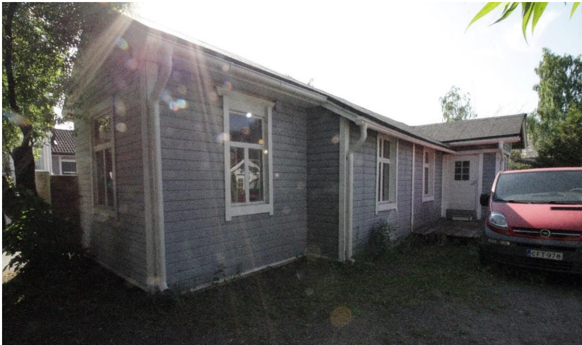
Kuva 5. Tontin itäreunalla oleva talourakennus. Kuvan oikeassa reunassa näkyy rakennukseen 2000-luvulla tehty kuisti. Rakennuksen ulkonäköä on kuvailtu edellä luvussa "Rakennuksen kuvaus".
