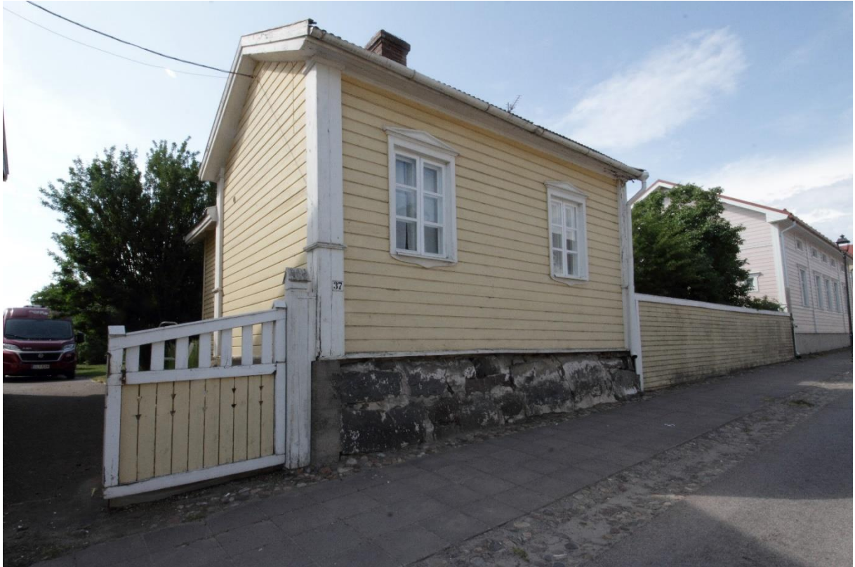
Kuva 6. Kuvassa on portinvartijan talon Kauppakadun puoleinen julkisivu. Kuvan vasemmassa reunassa näkyy portinvartijan talon ja päärakennuksen välissä oleva lautarakenteinen portti. Rakennuksen ulkonäköä on kuvailtu edellä luvussa "Rakennuksen kuvaus".
