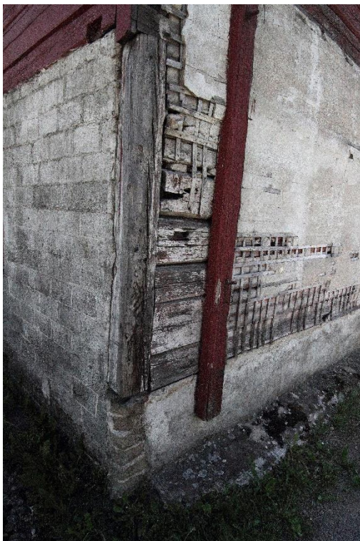
Kuva 3 Kuvassa näkyy eläinsuojan vuorausmateriaaleja. Pihapuoleinen seinä on vuorattu vaaleilla sementtitiilillä, jotka ovat seinähirsien kanssa samassa tasossa. Päädyssä puolestaan on betonista valettu kivijalka alimpien hirsien tilalla ja sen päällä hirret, jotka on vuorattu rappauksella. Rappaus on kulunut nurkasta ja sen alta näkyy rappauستا tukeva rimoitus. Rappauksen päällä on följari tukemassa hirsirakennetta.
