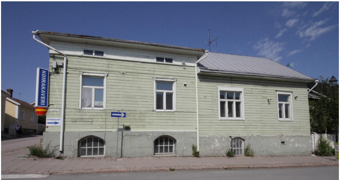
Kuva 2. Kohteen päärakennus Koulu- ja Kauppakatuojen kulmassa. Kuvassa näkyy rakennuksen Koulukadun puoleinen julkisivu. Rakennuksen Kauppakadun suuntainen rakennusosa on aumakattoinen ja Koulukadun puoleinen osa harjakattoinen. Rakennuksen ulkonäköä on kuvailtu edellä luvussa "Rakennuksen kuvaus".
