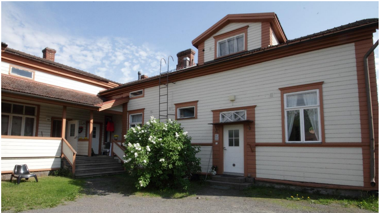
Kuva 3. Koulukadun puoleisen päärakennuksen pihan puoleinen julkisivu. Vasemmalla näkyy rakennuksen vanhempaa osaa, jonka edustalla kuvassa näkyy avokuisti. Oikealla näkyy rakennuksen Koulukadun suuntainen laajennusosa. Rakennuksen ulkonäköä on kuvailtu edellä luvussa "Rakennuksen kuvaus".
