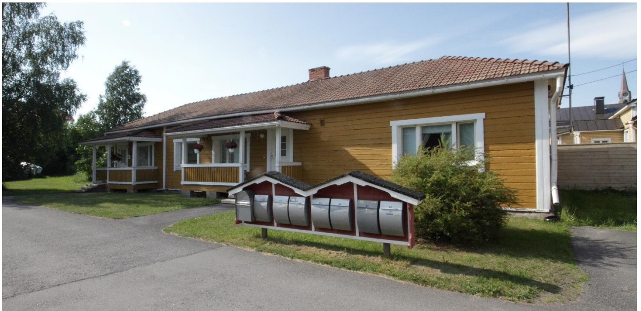
Kuva 5. Pihassa tontin pohjoisreunalla olevan asuinrakennuksen eteläulkisivu. Entinen talousrakennus on muutettu asunnoiksi 1900-luvun lopulla. Rakennuksen ulkonäköä on kuvailtu edellä luvussa "Rakennuksen kuvaus".
