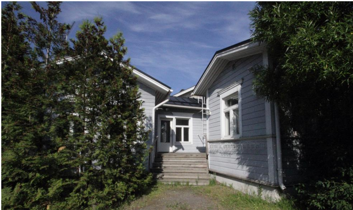
Kuva 7. Kohteen päärakennuksen pihanpuoleinen julkisivu. Kuvan oikeassa reunassa näkyy entinen sisäänkäyntikuisti, joka on muutettu asuinhuoneeksi. Keskellä näkyy uudelle sisäänkäynnille johtavat portaat. Kuvan vasemmassa reunassa näkyy taloon tehty uudisosa.
