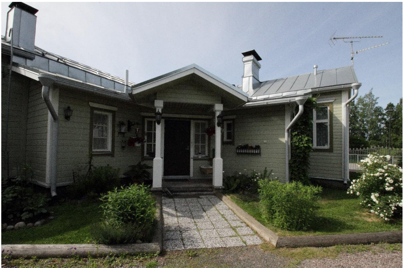
Kuva 2 Kohteen asuinrakennuksen pihajulkisivua määrittää 2000-luvun taitteessa rakennettu umpikuisti, joka sijoittuu vinkkelirakennuksen sisäkulmaan. Kuistin sisäkulma on viistetty ja sisäänkäynti on viisteestä. Sen yllä on sisäänkäyntikatoksen muodostava kattolyhty, jota kannattaa kaksi muotoiltua pilaria. Rakennuksen ulkonäköä on kuvailtu edellä luvussa "Rakennuksen kuvaus".
