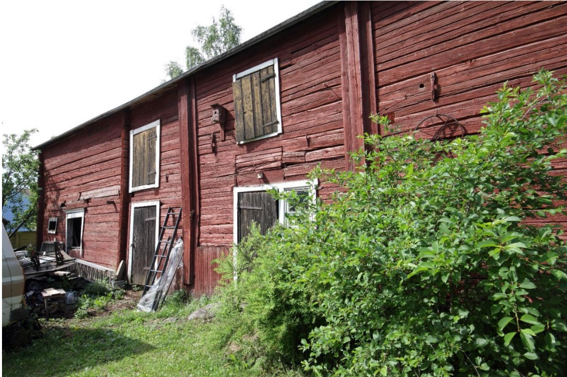
Kuva 6. Kuvassa on talousrakennuksen eteläpääty, jossa on sijainnut kuvan vasemmasta reunasta lukien navetta, karjakeittiö ja talli. Navettan oviaukon vieressä on pieni vaakaikkuna. Karjakeittiön oviaukon yllä on luukku yläkertaan. Tallin oven vieressä on kaksi ruutuinen pystyikkuna ja oven yllä on luukku yläkertaan. Hirsistä päätellen oven yllä on joskus ollut pieni vaakaikkuna.
