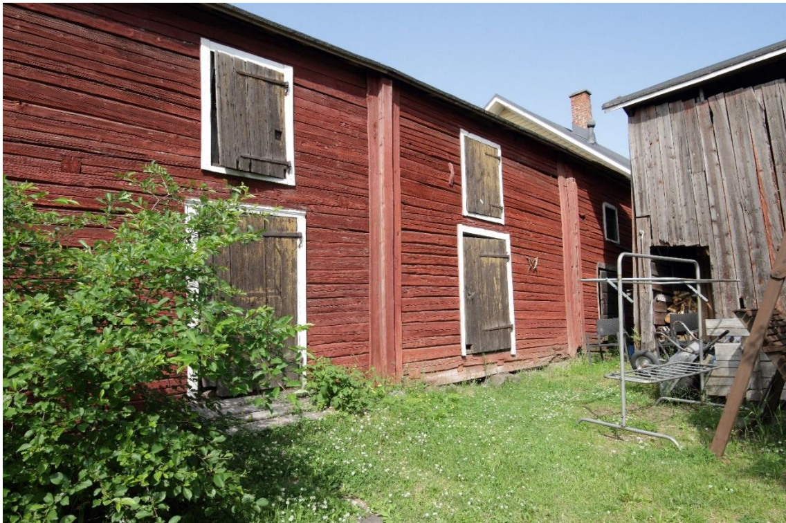
Kuva 5 Kuvan vasemmassa reunassa näkyy talousrakennuksen kolme varastoaittaa, joista kaksi on ollut vilja-aittoja ja yksi varastomakasiini. Aitat ovat kaksikerroksisia ja oviaukkojen yllä on luukut yläkertaan. Kuvan oikeassa laidassa näkyy aittaan nähden kulmittain oleva entisen pakarituvan päädyssä oleva halkoliiteri. Rakennusten ulkonäköä on kuvailtu edellä luvussa "Rakennuksen kuvaus".
