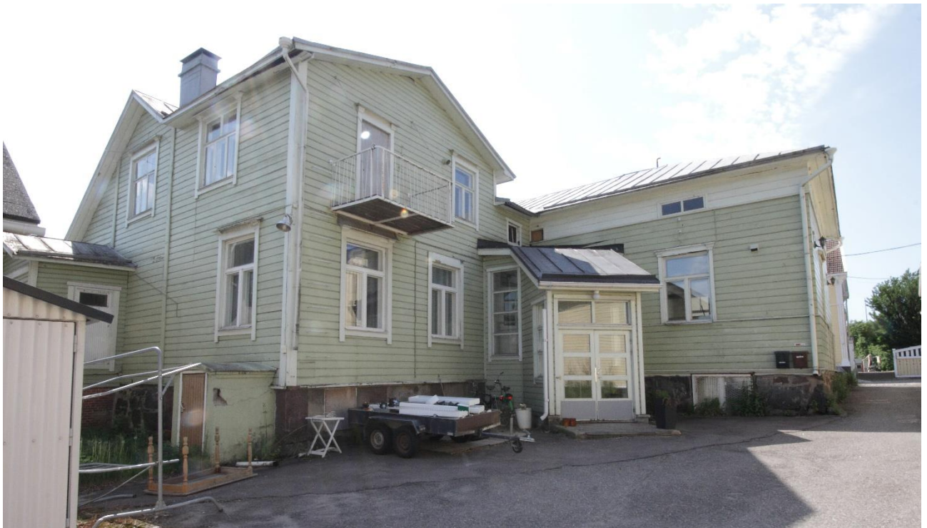
Kuva 4. Kohteen päärakennus Koulu- ja Kauppakatuojen kulmassa. Kuvassa näkyy rakennuksen pihan puoleiset julkisivut. Kuvan vasemmassa reunassa näkyy Koulukadun puoleisen rakennusosan pohjoispääty. Siinä on pihan puolella kaksikerroksinen poikkipääty. Kuvan oikeassa reunassa näkyy rakennuksen Kauppakadun puoleinen rakennusosa. Kulmassa on 1900-luvun lopulta oleva sisäänkäynti lasiovineen. Rakennuksen ulkonäköä on kuvailtu edellä luvussa "Rakennuksen kuvaus".
