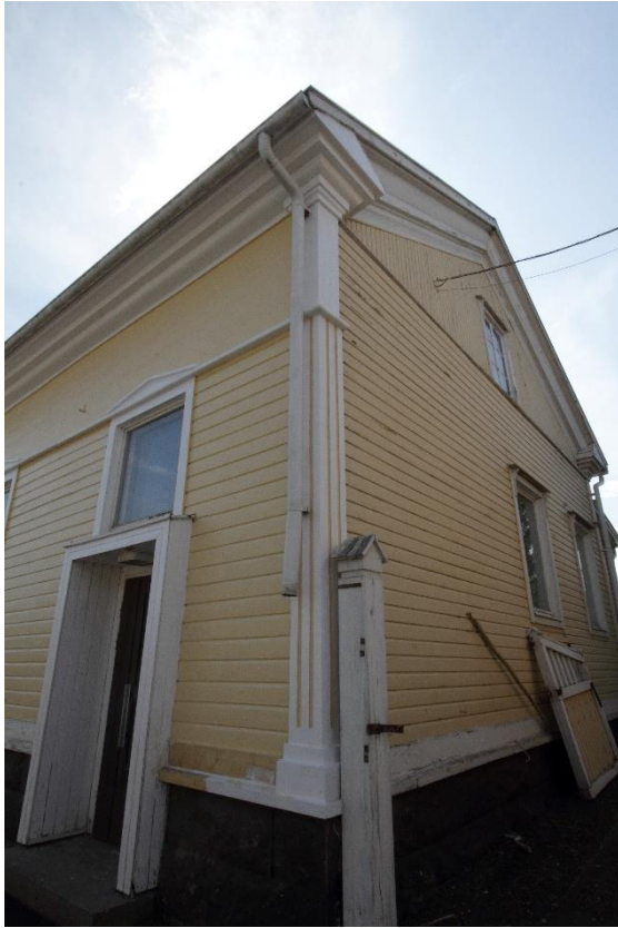
Kuva 4. Kuvassa näkyy Kauppakaudun puoleisen rakennusosan koristeelliset nurkkapilarit ja kattolistat. Rakennuksen ulkonäköä on kuvailtu edellä luvussa "Rakennuksen kuvaus".
