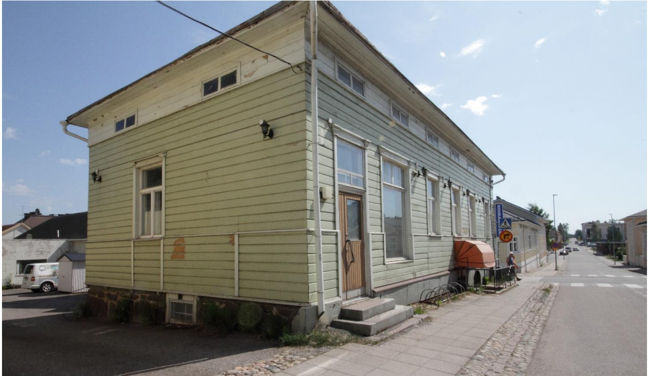
Kuva 3. Kohteen päärakennus Koulu- ja Kauppakatuojen kulmassa. Kuvassa näkyy rakennuksen Kauppakadun puoleinen julkisivu sekä sen pohjoispääty. Kuvan oikeassa reunassa näkyy Kauppakatu. Rakennuksen ulkonäköä on kuvailtu edellä luvussa "Rakennuksen kuvaus".
