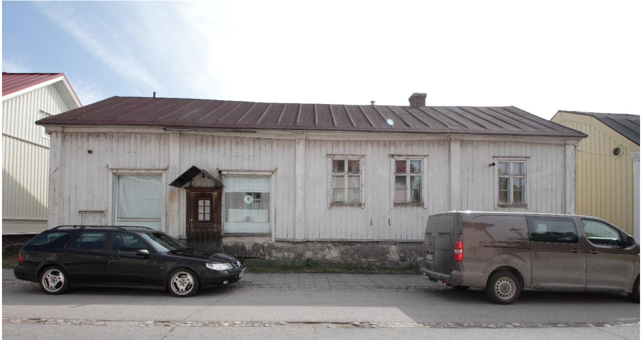
Kuva 2. Kohteen päärakennuksen kauppakadun puoleinen julkisivu. Rakennuksen pohjoispäädystä on ollut 1900-luvun alkupuoliskolla lihakauppa. Rakennuksen ulkonäköä on kuvailtu edellä luvussa "Rakennuksen kuvaus".
