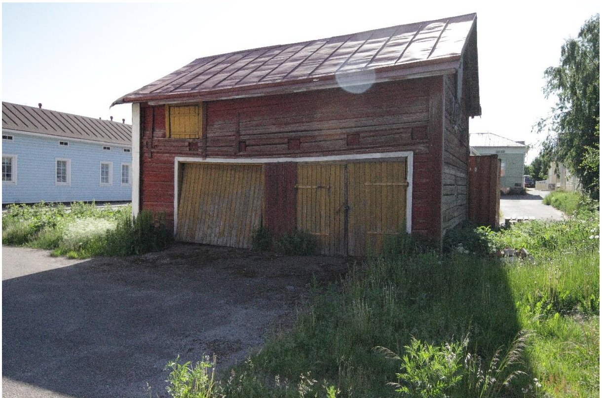
Kuva 7. Friemanin talon piharakennuksista on säästynyt autovajaksi muutettu entinen aitta tai makasiini. Rakennuksessa on vanha käsityönä tehty saumapeltikate.
