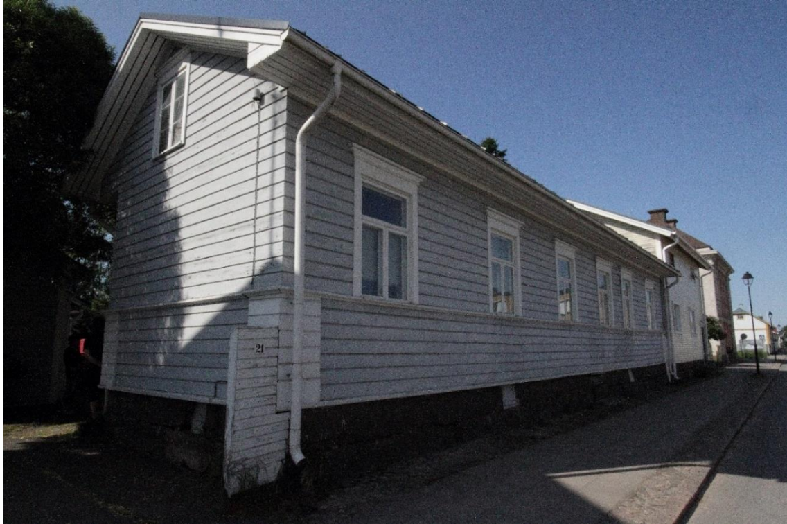
Kuva 2. Kohteen päärakennuksen katujulkisivu. Rakennuksen ulkonäköä on kuvailtu edellä luvussa "Rakennuksen kuvaus". Kuvan vasemmassa reunassa on kulku tontille. Talon päädyssä on lyhyt pätkä aitaa, portti on purettu pois. Kuvan oikeassa reunassa näkyy Koulukatua ja sen varrella olevia rakennuksia. Kohteen päärakennuksen vieressä on massoittelultaan jälleenrakennuskauden tyyppitaloja muistuttava talo ja sen takaa näkyy hieman entistä Suomen yhdyspankin kaksikerroksista taloa. Aivan kuvan oikeassa reunassa näkyy Raahen teatterin jugendtyylinen talo.
