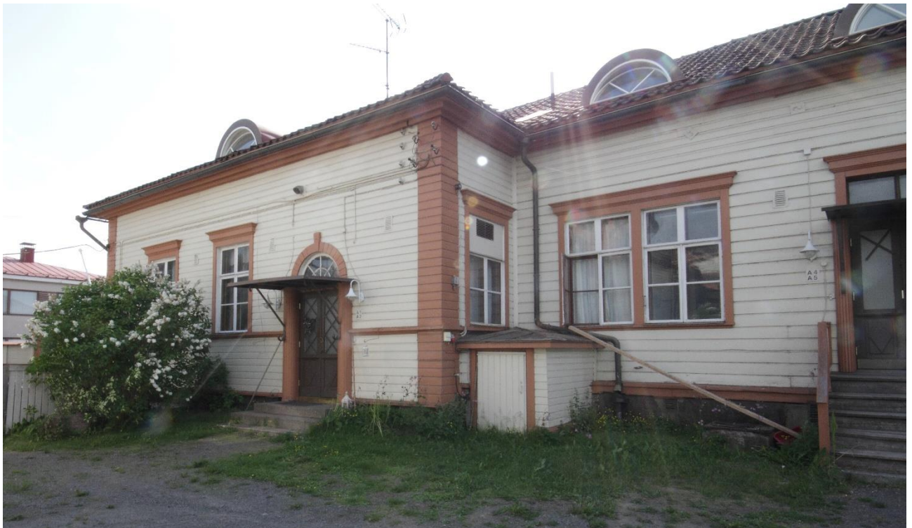
Kuva 7. Rantakadun puoleisen päärakennuksen pihan puoleinen julkisivu. Päärakennuksen ulkonäköä on kuvailtu edellä luvussa ”Rakennuksen kuvaus”.
