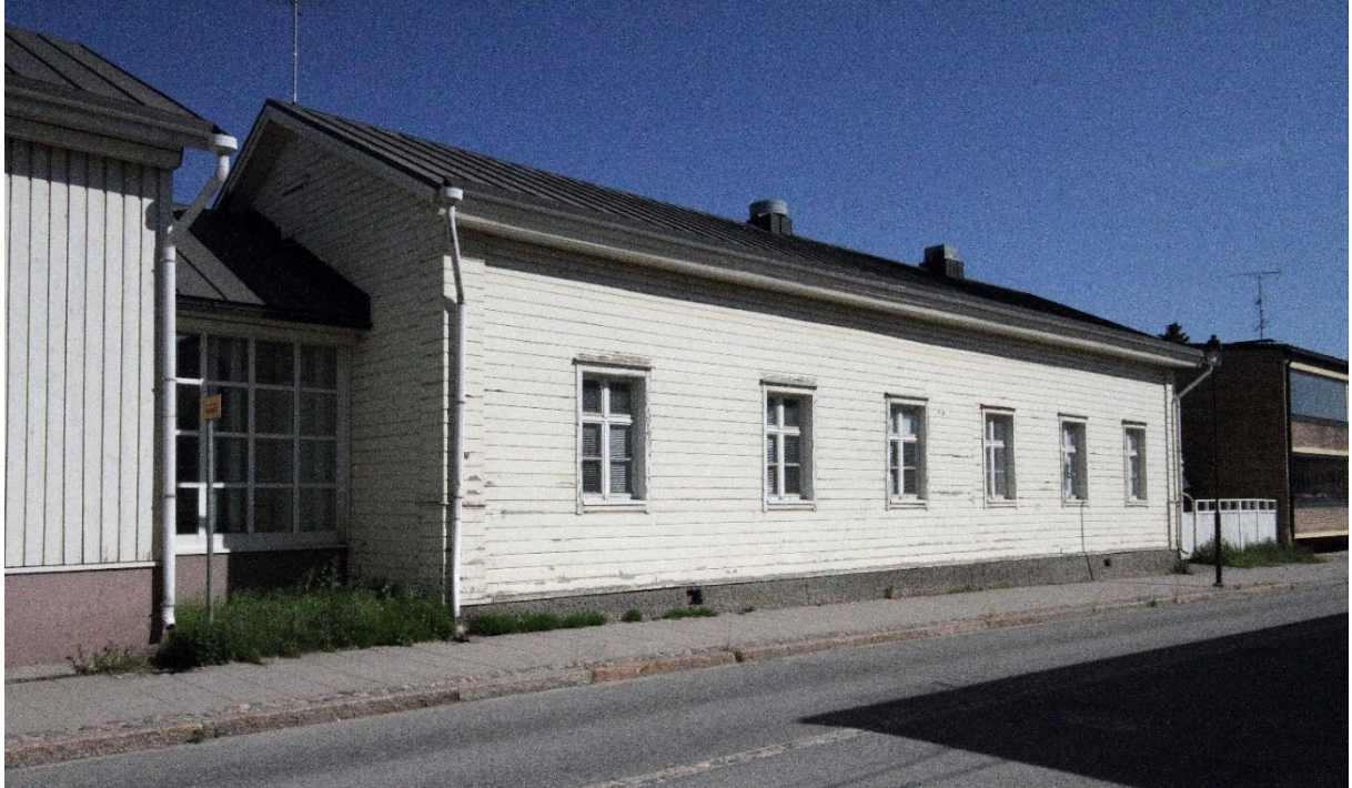
Kuva 2. Kirkkokadun varren vanha asuin- ja liikerakennus on osa 1990-luvulla rakennettua päiväkotia. Kadulle päin uudisosaa on mittakaavaltaan ja räystäskorkeudeltaan vanhaa osaa vastaava ja niiden välissä on lasiseinäinen sisäänveto rytmittämässä katunäkymää. Rakennuksen ulkonäköä on kuvailtu edellä luvussa "Rakennuksen kuvaus".
