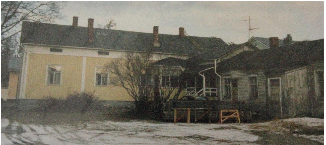
Kuva 4. Vanha valokuva 1990-luvun alusta. Kuvassa näkyy vasemmalla keltaiseksi maalattu vapaakirkko ja oikealla tontin itäreunalta puretti toinen asuinrakennus. Purettu rakennus näyttää kuvassa huonokuntoiselta ja se on ollut päärakennusta selvästi vaatimattomampi ulkoasultaan. Kuvan ottaja on tuntematon. Kuvälähde: Raahen vapaaseurakunta.
