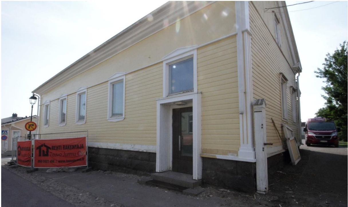
Kuva 3. Myös kohteen Kauppakadun puoleinen julkisivu on kunnostettu ja maalattu kesällä 2020. Seinän alareunan listoitusta on uusittu vanhan mallin mukaan ja sen maalaus on vielä kesken. Kuvassa näkyy voimakkaasti kehystetty, pienessä syvennyksessä oleva ovi entisiin pankin tiloihin. Rakennuksen ulkonäköä on kuvailtu edellä luvussa ”Rakennuksen kuvaus”.
