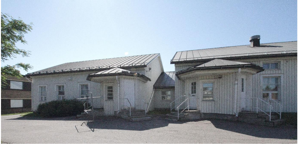
Kuva 4. Päiväkodin itäjulkisivu koostuu kahdesta käytävän toisiinsa liittämästä rakennusosasta, joiden mittakaava noudattaa vanhan kaupungin asuinrakennusten mittakaavaa. Itäjulkisivulla on kaksi sisäänkäyntikuistia, joiden muotokieli on moderni tulkinta mutterikuistista. Rakennuksen ulkonäköä on kuvailtu edellä luvussa ”Rakennuksen kuvaus”.
