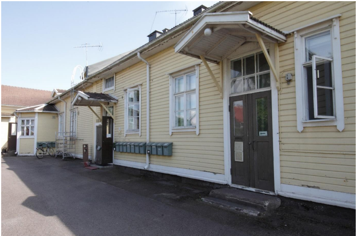
Kuva 5. Koulukadun puoleisen siiven pihajulkisivulla on kaksi sisäänkäyntiä, joiden päällä on katos. Ovet ovat ruskeaksi maalatut ikkunalliset pariovet. Kuvan vasemmassa reunassa näkyy lisäksi mutterikuisti, josta on myös sisäänkäynti rakennukseen. Pihajulkisivussa ei ole vastaavia koristeiluita kuin katujulkisivuissa. Rakennuksen edusta on kauttaaltaan asfaloitu. Rakennuksen ulkonäköä on kuvailtu edellä luvussa "Rakennuksen kuvaus".
