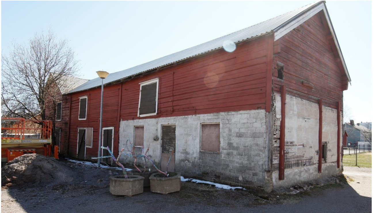
Kuva 2 Tontin eteläsivulle sijoittuu riviaitta, jonka länsipäätyä on käytetty eläinsuojana. Eläinsuojaa on luultavasti käytetty navettana tai tallina ja sen yläpuolella on ylinen heiniä varten. Eläinsuojan lisäksi rakennuksessa on kolme muuta aittahuonetta. Rakennuksen ulkonäköä on kuvailtu edellä luvussa "Rakennuksen kuvaus".
