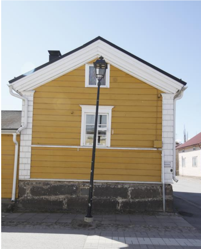
Kuva 3 Kohteen päärakennuksen pääty Saaristokadun puolella. Rakennuksella on melko korkea kivijalka lohkokivistä ja julkisivua jäsentää koristeelliset nurkkapilasterit ja vaakalista ikkunoiden alla. Rakennuksen ulkonäköä on kuvailtu edellä luvussa "Rakennuksen kuvaus".
