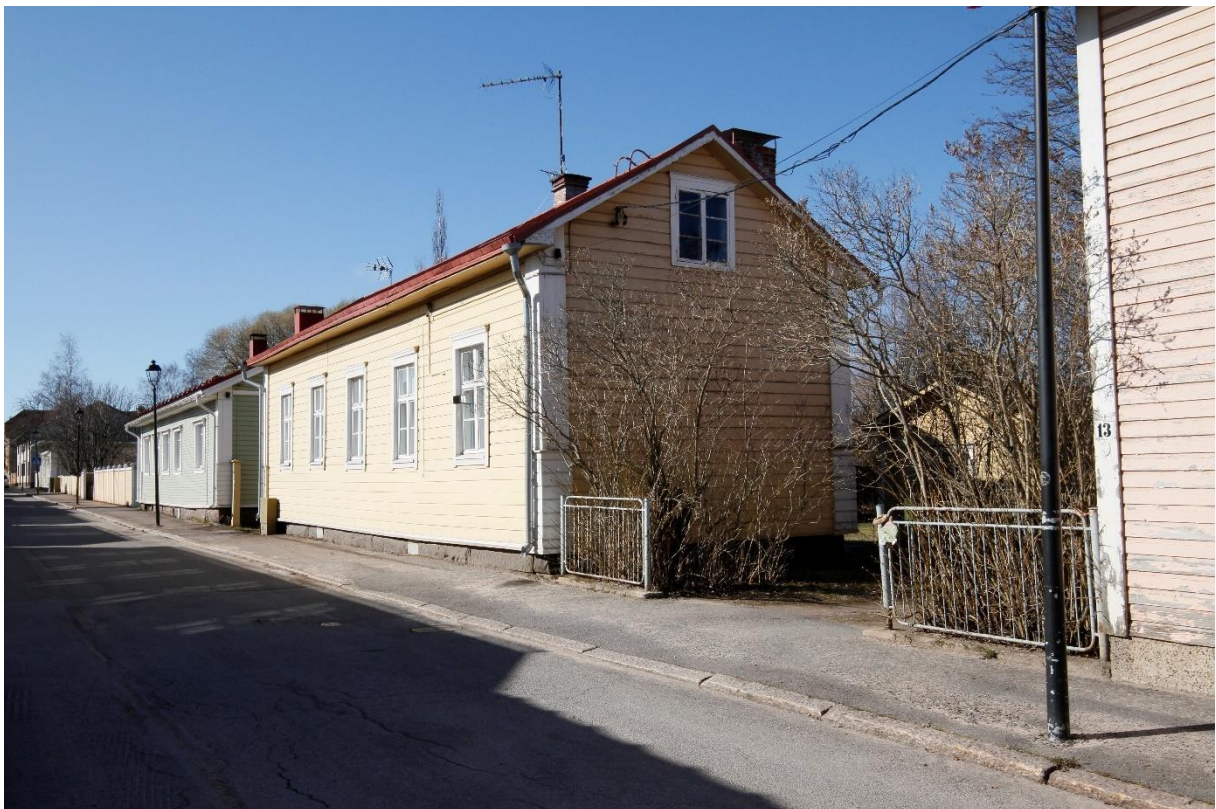
Kuva 2 Kohteen päärakennuksen kadun puoleinen julkisivu ja pääty. Rakennuksen kivijalka on yhden kivikerran korkuinen ja julkisivua jäsentää koristeelliset nurkkapilasterit. Rakennuksen ulkonäköä on kuvailtu edellä luvussa "Rakennuksen kuvaus".
