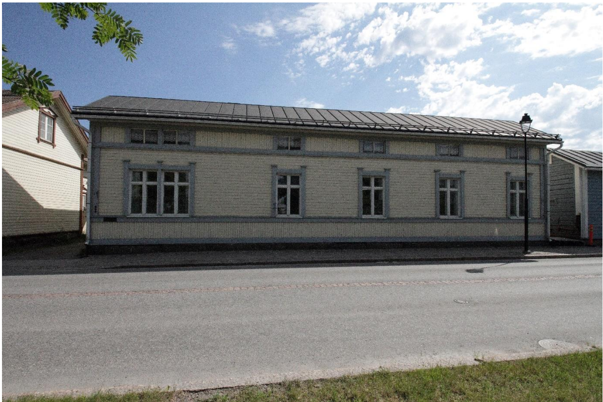
Kuva 2 Rantakatu 16 c:n asuinrakennus on melko suuri ja julkisivu on rikkaasti jäsennöity. Rakennuksen ja naapuritalojen väliin jää vain kapeat kulkuyhteydet pihaille. Rakennuksen ulkonäköä on kuvailtu edellä luvussa "Rakennuksen kuvaus".
