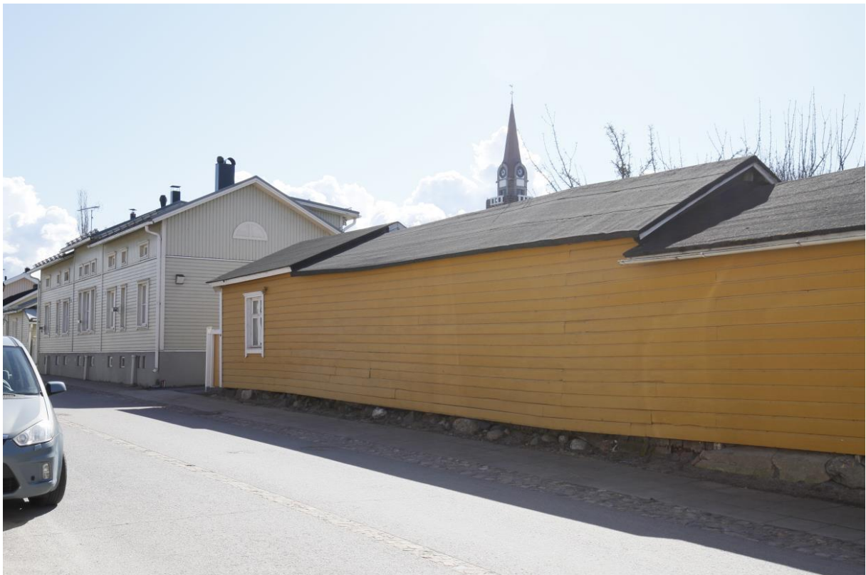
Kuva 4 Kohteen talousrakennukset on vuorattu yhtenäisesti vaakalaudoituksella Saaristokadun puolella. Talousrakennusten ollessa matalia vaikutelma on aitamainen. Useasta eri rakennusosasta koostuvan rakennusrivistön perustukset ovat eläneet ja saaneet seinän aaltoilemaan. Taustalla näkyy Raahen kirkon torni. Rakennuksen ulkonäköä on kuvailtu edellä luvussa "Rakennuksen kuvaus".
