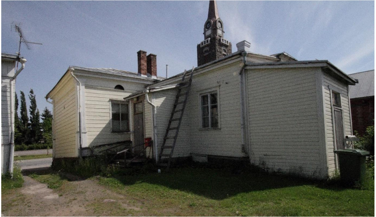
Kuva 4. Kohteen eteläisemmän asuinrakennuksen pihan puoli. Vinkkelin nurkassa on lapekattoinen laajennusosa, jonka kummallakin sivulla on umpinaiset sisäänkäyntikuistit. Kirkon torni näkyy rakennuksen yli pihamaalle. Rakennuksen ulkonäköä on kuvailtu edellä luvussa "Rakennuksen kuvaus".
