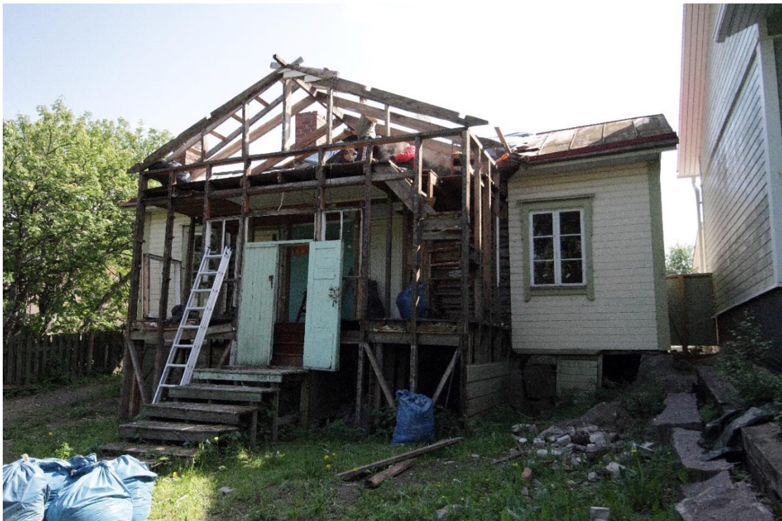
Kuva 3 Vanhassa asuinrakennuksessa on pihan puolella ollut umpikuisti, jonka rakenteita uusitaan parhaillaan. Kuistin vanha pariovi on säilytetty. Rinteessä olevan talon kivijalka on pihan puolelta korkea ja tehty osittain luonnonkivistä. Rakennuksen ulkonäköä on kuvailtu edellä luvussa "Rakennuksen kuvaus".
