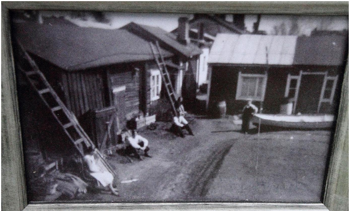
Kuva 13 Kohteen talousrakennusrivistö sekä tontin perällä ollut rakennus 1930-luvun alussa. Talousrakennusrivistössä näkyy vasemmalta alkaen liiteri, makasiini, perämökin eteinen ikkunoineen ja perämökki. Perämökin eteisen sivulla, nykyisen oven kohdalla, on pieni ulkoneva umpikuisti. Mökin ikkuna ei hahmotu kuvasta. Kuvassa mökissä on savupiippu, joka on myöhemmin purettu pois. Kuvassa näkyy myös osittain tontin perällä ollut talousrakennus, johon sijoittui sauna, navetta ja huussi. Navetta ja huussi on purettu viimeistään 1970-luvulla. Sauna on edelleen jäljellä. Kuvalähde: Airi Ruohosen omistuksessa oleva valokuva 1930-luvun alusta.
