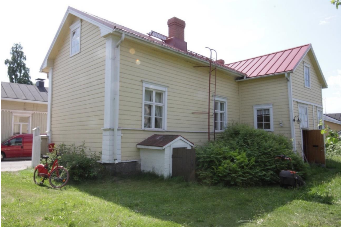
Kuva 3. Kohteen asuinrakennuksessa on pihan puolella iso umpikuisti, josta on sisäänkäynti rakennukseen sekä kulku ullakkokerrokseen. Kellariin on myös sisäänkäynti pihalta. Pihajulkisivussa ei ole haukkaikkunoita. Rakennuksen ulkonäköä on kuvailtu edellä luvussa "Rakennuksen kuvaus".
