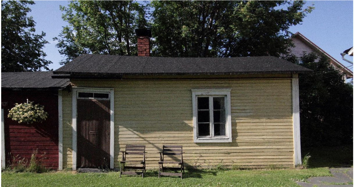
Kuva 5 Talousrakennuksen itäpäädyn asuintupa. Tuvassa on 6-ruutuinen pystyikkuna ja sormipaneloitu, ruskeaksi maalattu ovi, jossa on postiluukku. Rästyslinja on hieman ylempänä kuin rakennuksen muilla osilla. Rakennuksen nurkissa on hyvin yksinkertaiset pilasteri piiloponttilaudasta. Niillä ei ole jalustaa eikä varsinaista kapiteelia. Seinäpintaa jäsentää seinän yläreunassa oleva vaakalista, joka jatkuu pilasterin päällekin. Listan yläpuolelta sinä on vuorattu muutaman laudan levyisellä piiloponttilaudoituksella ja pilasteri kapenee listan yllä hieman kapeammaksi. Rakennuksen ulkonäköä on kuvailtu edellä luvussa "Rakennuksen kuvaus".
