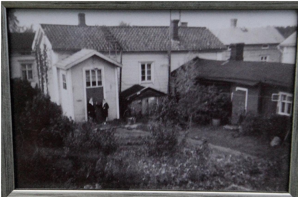
Kuva 6 Kohteen päärakennus, pakaritupa ja asuinmökki 1940-50 -luvulla otetussa valokuvassa. Kuvassa päärakennus vastaa hahmoltaan, vuoraukseltaan ja ikkuna-aukotukseltaan nykyistä, mutta siinä on vesikatteena tiilet saumapellin sijasta. Kulmittain asuinrakennukseen nähden on pakaritupa, jonka paikalle on 1970-luvulla rakennettu uudisosa. Kuvan oikeassa reunassa pakarituvan vieressä näkyy asuinmökkiä ja sen ikkuna. Ikkuna on edelleen paikallaan. Kuvan etualalla näkyy pihalla olleen keittiötarhan hyötykasveja. Rakennuksen ulkonäköä on kuvailtu edellä luvussa "Rakennuksen kuvaus". Kuvälähde: Airi Ruohosen omistuksessa oleva valokuva 1940-50 -luvulta.
