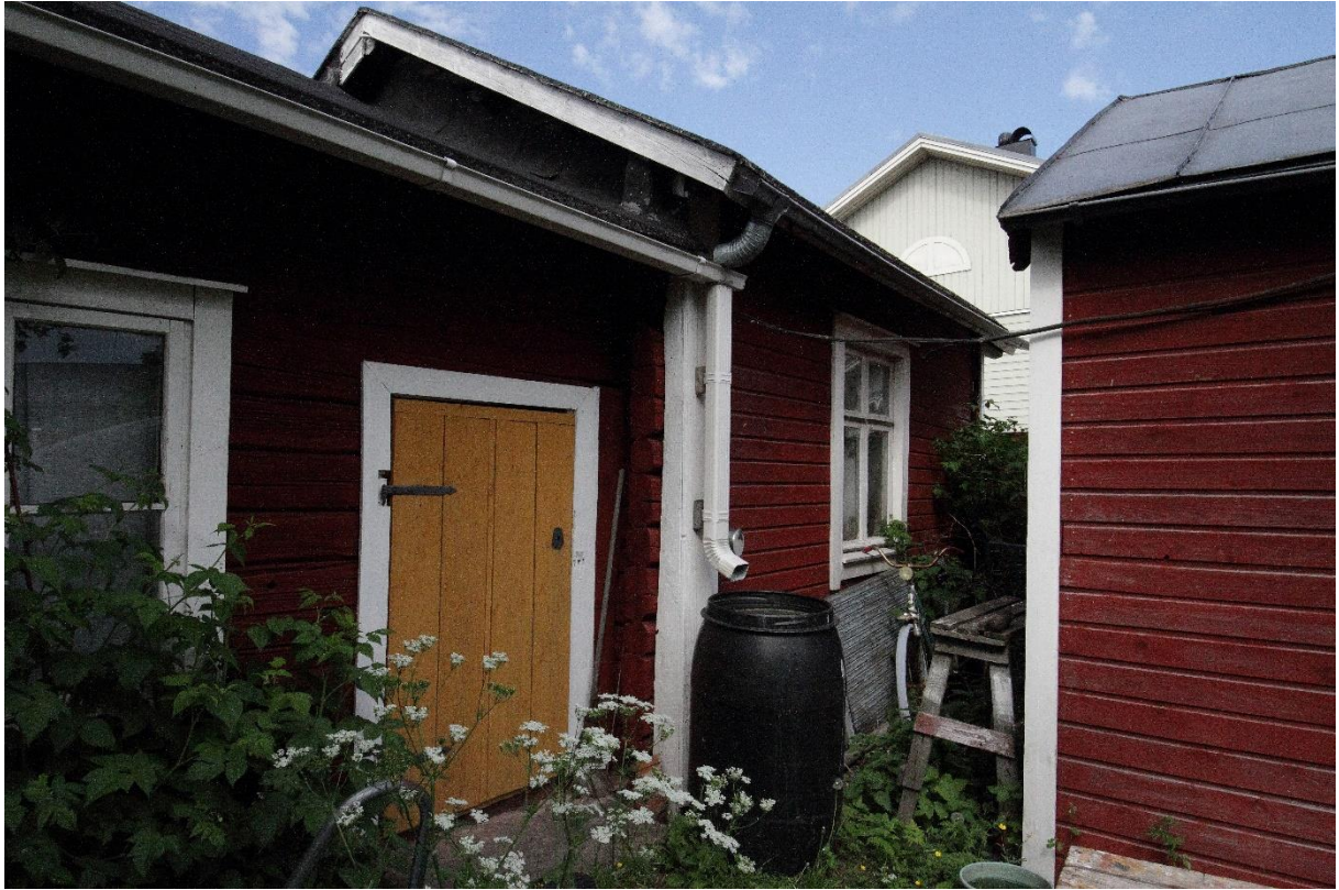
Kuva 11 Kuvan vasemmassa reunassa näkyy perämökin eteistä ja ovi, keskellä kuvaa on perämökki. Perämökissä on 4-ruutuinen pystyikkuna. Kuvan oikeassa reunassa näkyy erillinen saunarakennus. Sen ja perämökin väliin jää vain kapea aukko. Aukosta näkyy viereisen tontin uudisrakennusta.
