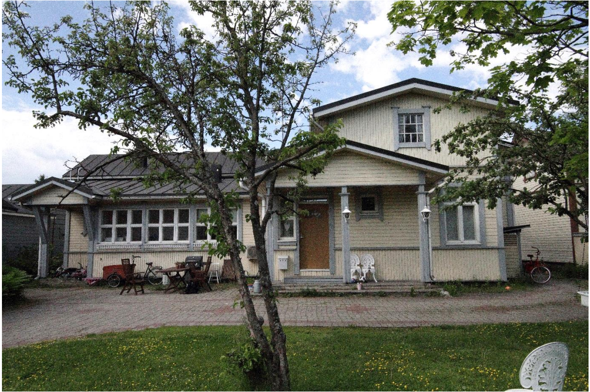
Kuva 3 Rantakatu 16 c:n asuinrakennusta on laajennettu useaan otteeseen. 1989 pihan puolelle on rakennettu poikkipäätty, jossa on eteinen, kodinhoitotilat ja makuuhuone sekä lapekattoinen laajennus, johon sijoittuu keittiö. Rakennuksen ulkonäköä on kuvailtu edellä luvussa "Rakennuksen kuvaus".
