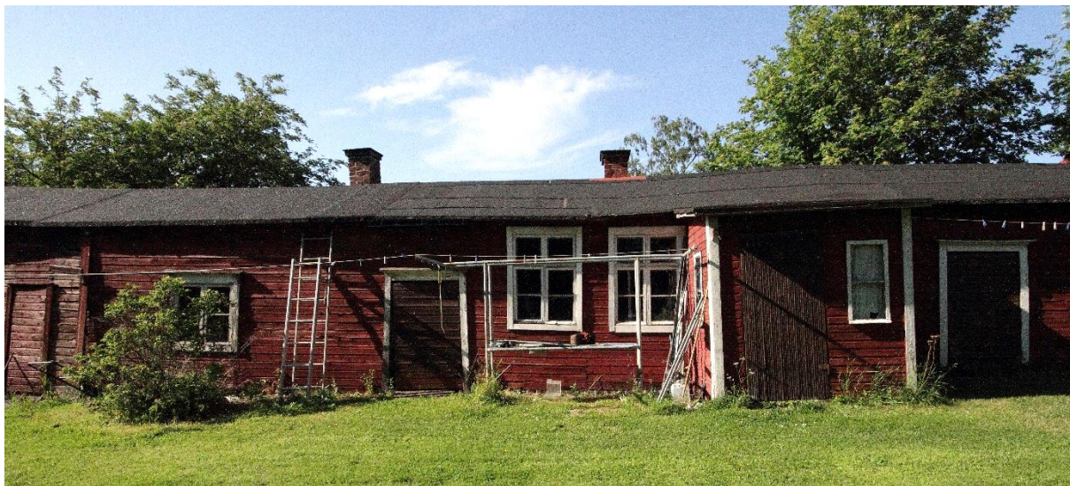
Kuva 7 Kuvan oikeassa reunassa näkyy rakennukseen sijoittuva toinen asuintupa ja sen lapekattoinen umpikuisti. Tuvassa on kaksi 6-ruutuista pystyikkunaa. Ovi on ruskeaksi maalattua sormipanelia. Vasemmassa reunassa on entiseltä eläinsuojalta vaikuttava rakennusosa, joka on saattanut olla navetta. Sinne johtaa matalahko ruskeaksi maalattu laudoitettu ovi. Oven vasemmalla puolella on pieni 4-ruutuinen ikkuna. Rakennuksen ulkonäköä on kuvailtu edellä luvussa ”Rakennuksen kuvaus”.
