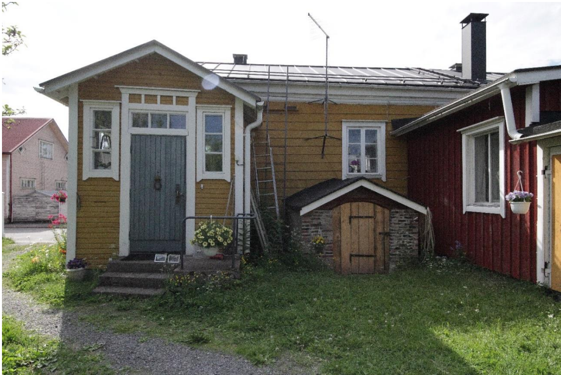
Kuva 5 Kohteen päärakennuksen pihan puoleisella julkisivulla on sisäänkäynti umpikuistin kautta. Kuistin vieressä on kellarin matala sisäänkäynti. Talousrakennusten rivistö on kiinni päärakennuksessa. Kuvan oikeassa reunassa näkyy entisen pakarin paikalle 1970-luvulla tehty uudisosa. Rakennuksen ulkonäköä on kuvailtu edellä luvussa "Rakennuksen kuvaus".
