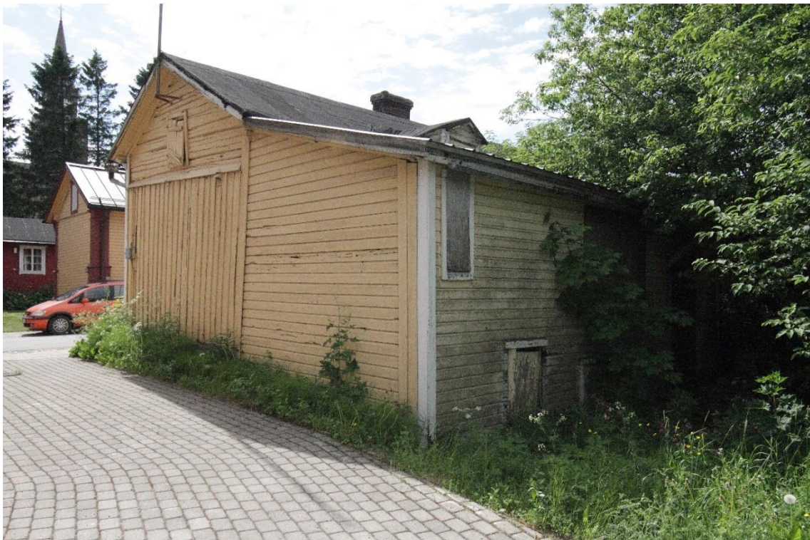
Kuva 3 Saaristokatu 16 a:n pihan puolella on huoneen ja eteisen käsittävä laajennus. Pihan kasvillisuus on runsasta ja villiintynyttä. Naapuritontilla sijaitsevan uudistalon pihalle johtaa kivetty ajotie talojen välistä. Rakennuksen ulkonäköä on kuvailtu edellä luvussa "Rakennuksen kuvaus".
