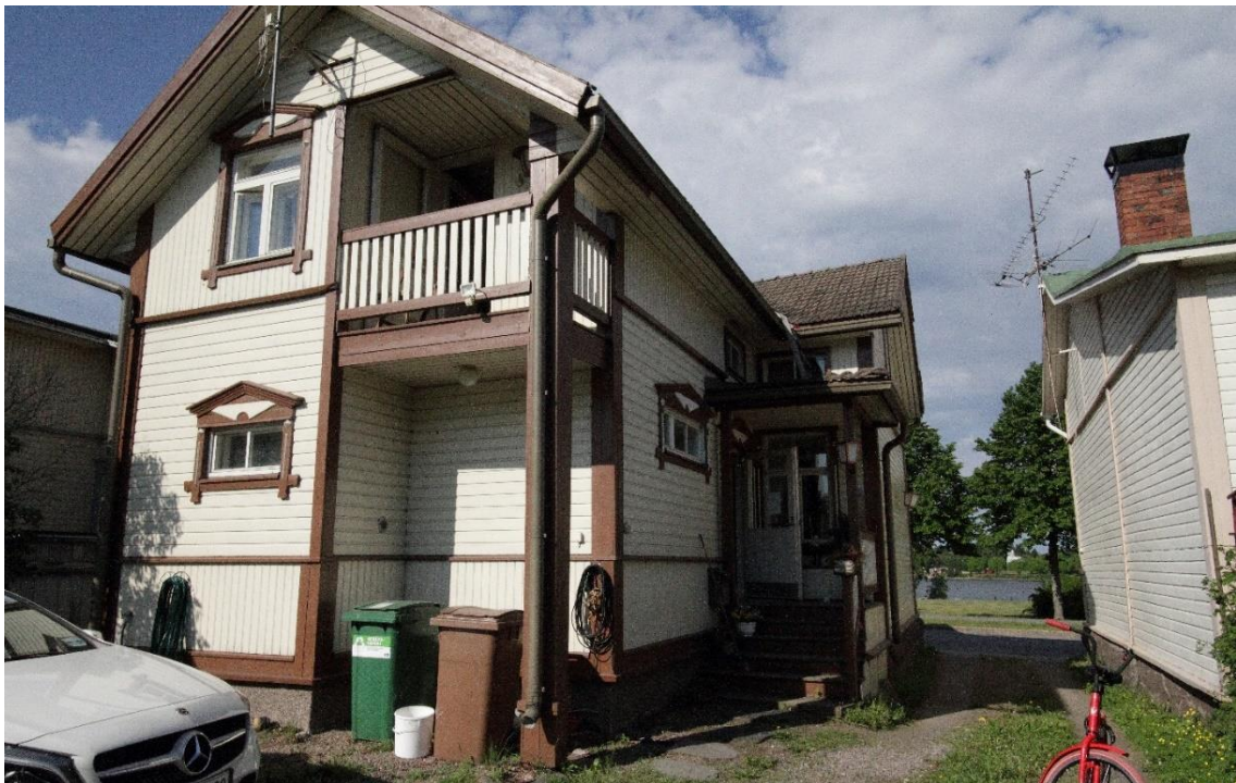
Kuva 4 Rantakatu 16 b:n asuinrakennusta on laajennettu pihan puolella leveällä poikkipäädellä. Kuvan oikeassa laidassa näkyvä talo sijaitsee samalla tontilla, mutta taloilla on omat rakennusten, aitojen ja kasvillisuuden rajaamat pihapiirinsä. Talojen välistä näkyy Rantakadun ja Rantapuiston yli merelle Pikkulahdelle. Rakennuksen ulkonäköä on kuvailtu edellä luvussa "Rakennuksen kuvaus".
