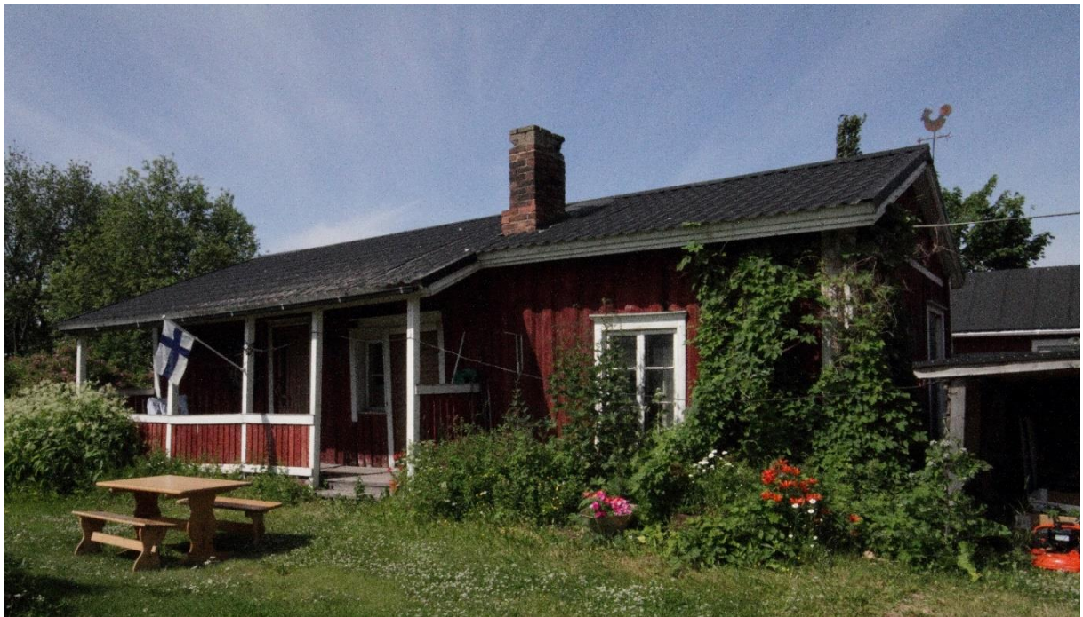
Kuva 7. Pihan pohjoisreunalla olevassa talousrakennuksessa on luultavasti sauna. Rakennus on luultavasti alkujaan ollut myös asuinkäytössä. Rakennuksen edustalla on avokuisti ja julkisivua peittää köynnös. Rakennuksen ulkonäköä on kuvailtu edellä luvussa "Rakennuksen kuvaus".
