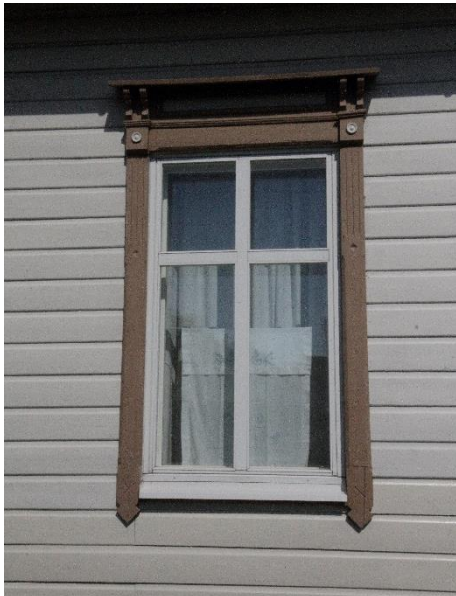
Kuva 5. Rakennuksen neliruutuiset ikkunat on uusittu vanhan mallin mukaan. Koristeellisissa palkistokehyksissä on konsolien kannattama lippalauta, koristeruusukkeet ja geometrisiä koristekaiverruksia.
