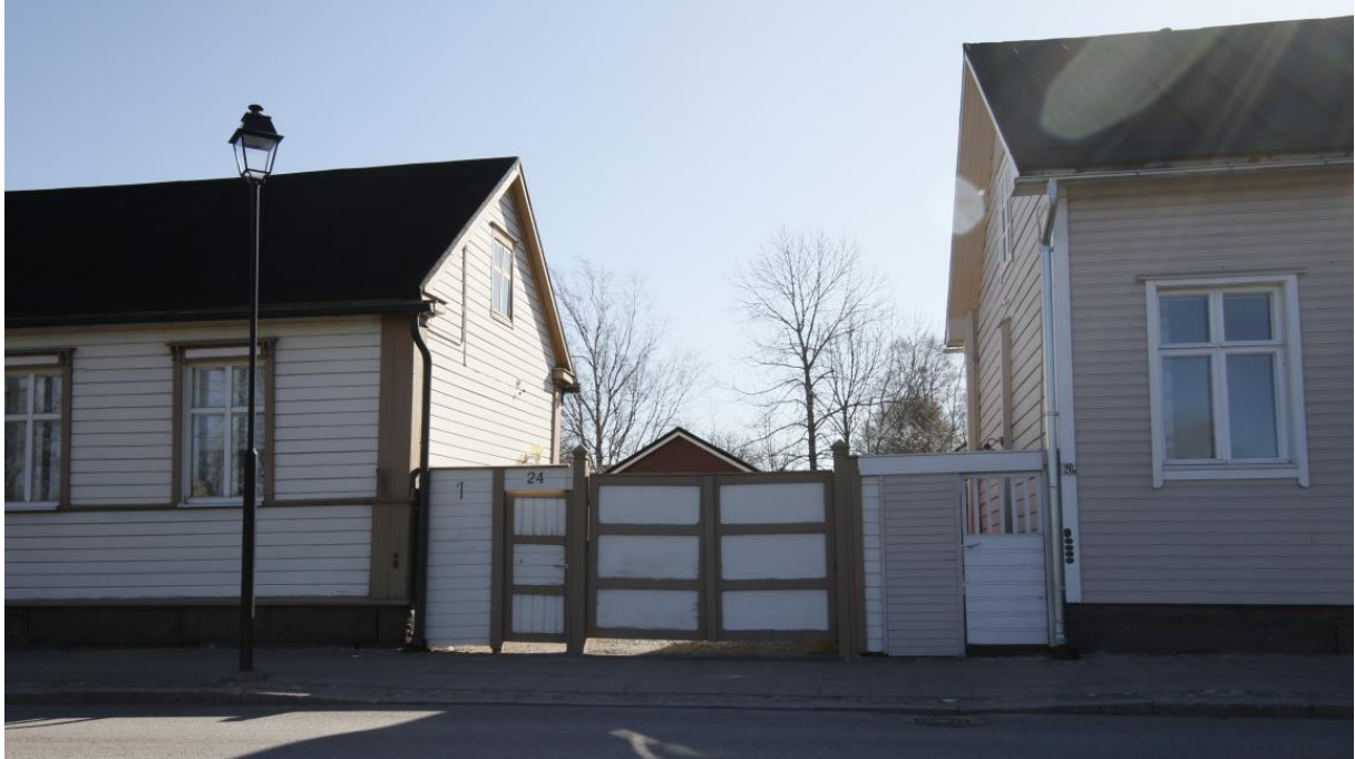
Kuva 2. Kohteen asuinrakennus Rantakadun varrella sekä eteläpuolinen naapuritalo. Rakennusten välissä on aita ja kohteen portti. Portin pylväiden päissä on pyöreät koristeet. Portin vieressä on kapeampi jalankulkijalle sopiva portti. Kohteen asuinrakennuksen ulkonäköä on kuvailtu edellä luvussa "Rakennuksen kuvaus". Viereinen rakennus on hieman kookkaampi yksikerroksinen, harjakattoinen rakennus, joka on vaakavuorattu ja vaalean punaiseksi maalattu. Ikkunoiden kehykset ovat yksinkertaiset.
