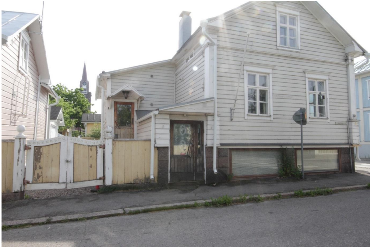
Kuva 3. Kohteen isomman asuinrakennuksen päätyjulkisivu Kauppakadulla. Kellarissa on isot ikkunat entisiin liiketiloihin ja kadulta johtaa ovi kellarin vieviin portaisiin. Isomman ja pienemmän asuintalon välissä on aita ja koristeellinen portti. Portin pylväiden päässä on pyöreät koristeet ja portin ylälaidassa on kasviaiheiset koristemaalaukset. Talojen välistä näkyy kirkon torni. Rakennusten ulkonäköä on kuvailtu edellä luvussa "Rakennuksen kuvaus".
