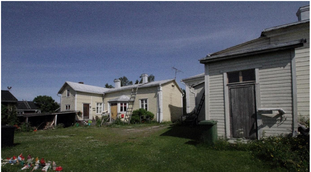
Kuva 5. Kohteen pohjoisemmän asuinrakennuksen pihan puoli. Pihan puolella on mutterikuisti. Kuvan oikeassa reunassa näkyy eteläisemmän asuinrakennuksen länsijulkisivulla oleva sisäänkäyntikuisti. Rakennusten ulkonäköä on kuvailtu edellä luvussa "Rakennuksen kuvaus".
