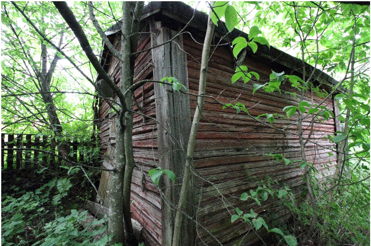
Kuva 4 Tontin länsireunalla on hirsirakenteinen aitta, jota on ilmeisesti käytetty kengityspajana. Rakennuksen ulkonäköä on kuvailtu edellä luvussa "Rakennuksen kuvaus".
