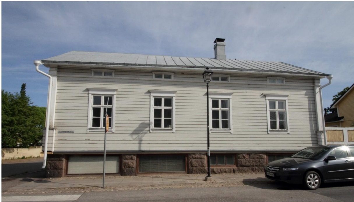
Kuva 2. Kohteen isomman asuinrakennuksen Corténkadun puoleinen pitkä julkisivu. Kivijalassa on kaksi isompaa ikkunaa liiketiloihin ja kaksi pienempää ikkunaa alkuperäiseen kellariin. Rakennuksen ulkonäköä on kuvailtu edellä luvussa "Rakennuksen kuvaus".
