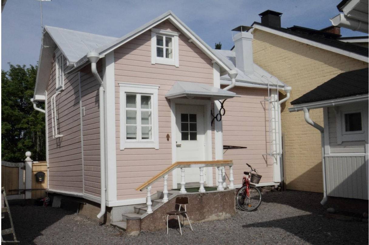
Kuva 5. Pienemmän asuinrakennuksen pihan puoleisella julkisivulla on umpikuisti 1990-luvun lopulta. Ulko-ovi on uusi, mutta ikkunat ovat vanhoja kierrätysikkunoita. Rakennus sijoittuu aivan kiinni pohjoispuoliseen naapuritaloon, jonka päätyseinä on tiilivuorattu. Rakennuksen ulkonäköä on kuvailtu edellä luvussa "Rakennuksen kuvaus".
