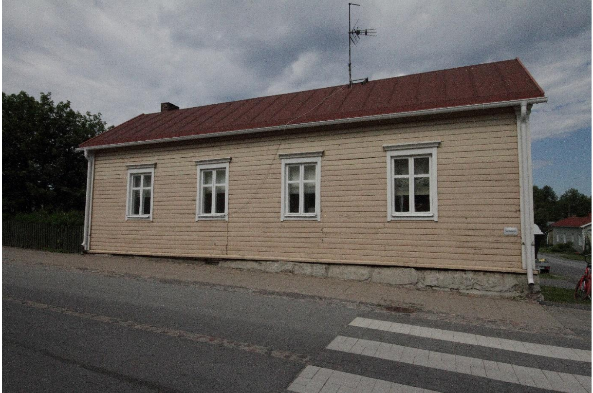
Kuva 2 Kirkkokatu 5:n Saaristokadun puoleinen pitkä julkisivu. Rinteeseen sijoittuvan talon kivijalka on Saaristokadun puolella matala. Rakennuksen ulkonäköä on kuvailtu edellä luvussa "Rakennuksen kuvaus".
