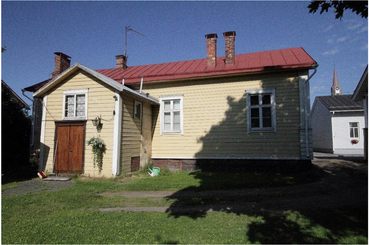
Kuva 3 Kohteen päärakennuksen pihapuoleinen julkisivu. Sisäänkäynti on umpikuistin kautta parioven kautta. Portaat ovat kuistin sisällä. Kellarin sisäänkäynti jää kuistin taakse piiloon. Kirkon torni näkyy pihalle talojen välistä. Rakennuksen ulkonäköä on kuvailtu edellä luvussa "Rakennuksen kuvaus".
