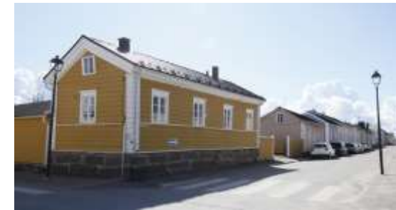
Kuva 51. Näkymä Kauppakatua pitkin etelään Saaristokadun risteyksestä. Kulmatalon vuoraus on Raahelle tyypillistä puuempireä.
