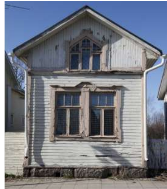
Kuva 17. Saaristokadun keskivaiheilla on Raahen kaupunkikuvulle harvinainen poikkipäätäinen asuinrakennus. Se saattaa olla asunnoksi muutettu talusrakennus. Jugend-ikkunat ovat koristeelliset.
