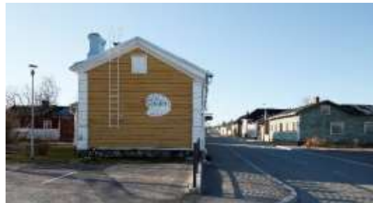
Kuva 140. Entinen Lybeckerin kotiteollisuuskoulun rakennus Reiponkadun varrella. 1800-luvun alusta oleva rakennus on vaakavuorattu ja kullmissa on Raahen puuempirelle tyypilliset pilasterit.
