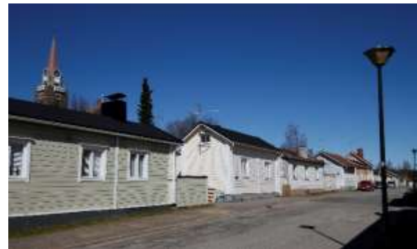
Kuva 61. Reiponkatua reunustaa pienet merimiesten ja vaatimattomien käsityöläisten vanhat asuinrakennukset. Muutamien talojen julkisivujen vuorauksessa ja jäsentelyssä näkyy kiviarkkitehtuuria jäljittelevä empire. Talojen koristeellisuus ja ikkunakehykset ovat vähäeleisiä. Kirkon torni näkyy talojen takaa.
