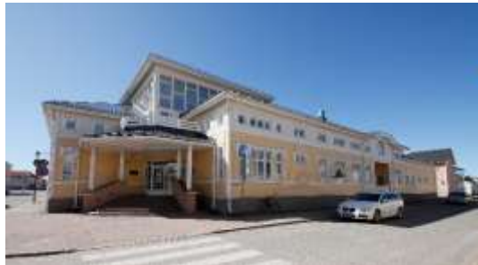
Kuva 88. Toimintakeskus Brahenkadun ja Reiponkadun risteyksessä. Kookas rakennus ei oikein istu Reiponkadun alkujaan pienipiirteisen rakennuskannan sekaan. Kulmaan sijoitettu sisäänkäynti muodostaa pienen aukion rakennuksen edustalle.
