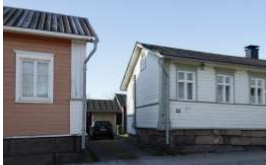
Kuva 23. Saaristokadun varren rakennuksissa näkyy raahelaiselle puuempirelle tyypillisiä piirteitä: leveä vaakalaudoitus, nurkkapilasterit kapiteeleineen ja ikkunalinjoja myötäilevä seinäpinnan jatkava lista.
