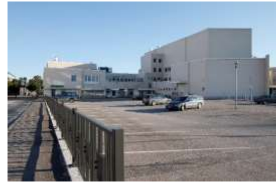
Kuva 142. Kiinteistö Oy Kauppaporvari sijaitsee tarkastelualueen eteläpuolella korttelin eteläosassa. Kuvassa näkyy etualalla Kauppaporvarin avoin ja asfaltoitu pysäköintialue ja takana rakennuksen matala itäsiipi, johon sijoittuu liike- ja toimistotiloja sekä korkea länsiosa, jossa on mm. Raahesali.
