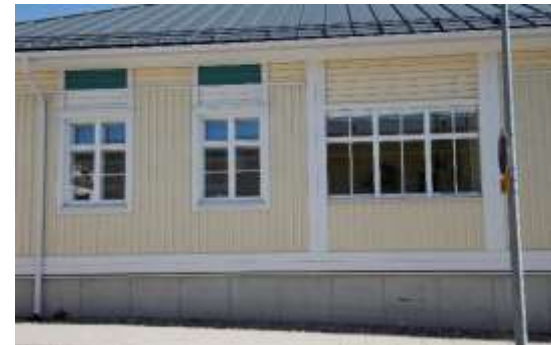
Kuva 134. Koulu- ja Kauppakatuojen risteyksessä olevan uudisrakennuksen julkisivu jäljittelee vanhempien rakennusten empiretyyliä. Pystyikkunoiden yllä on haukkaikkunoita jäljittelevät tummat kasetoinnit. Sisäänvedetty parveke ei riko julkisivua. Empirelle tyypilliset ikkunoiden koristeelliset kehykset ja pilastereiden jalustat ja kapiteelit puuttuvat rakennuksesta.
