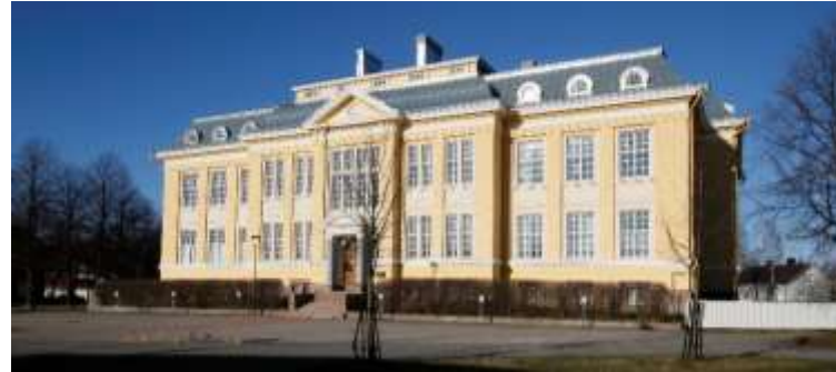
Kuva 162. Raahen keskuskoulun länsijulkisivu. Aumakaton muodossa näkyy ranskalaisvaikutteisen uusrenessanssin vaikutus samoin kuin pääsisäänkäynnin kaarihaiheessa. Klassismille tyypillisiä piirteitä puolestaan ovat pääsisäänkäynnin päätykolmioaihe ja ensimmäisessä kerroksessa käytetyt doorilaiset pylväät ja toisessa kerroksessa käytetyt joonilaiset pylväät.
