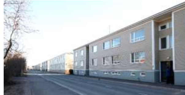
Kuva 39. Näkymä Palokunnankadun varrelta. Kadun varrelle sijoittuvat kaksi-kerroksiset lamellikerrostalot muodostavat muurimaisen monotonisen näkymän, vaikka julkisivujen jäsentelyssä onkin hieman vaihtelua. Rakennukset ovat 4. korttelissa puuvuorattuja.
