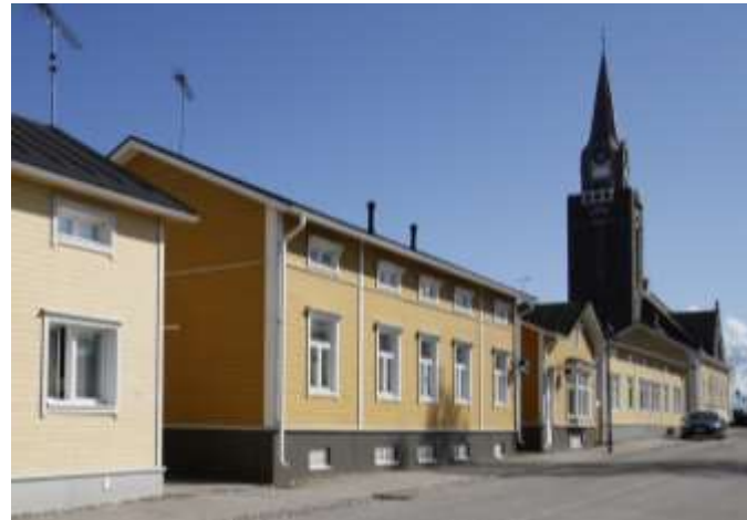
Kuva 55. Cortenkadun varren rakennuskanta on uusiutunut 2000-luvun taitteessa, mutta sopeutuu hyvin massoitteensa ja julkisivujen käsittelyn ansiosta muuhun rakennuskantaan. Kirkon torin näkyy hyvin Cortenkadulle.
