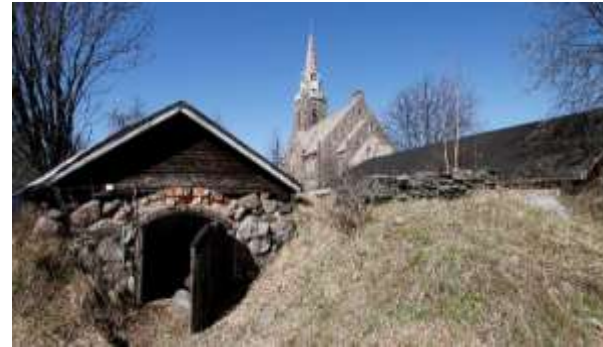
Kuva 60. Rinteeseen osittain maanalle rakennetut kirkkokellarit sijaitsevat kirkon takana pusikoituvassa rinteessä. Sisäänkäynti kellareihin on alarinteen puolelta. Taustalla näkyy Raaken kirkko.
