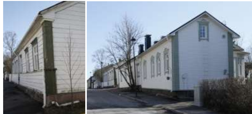
Kuva 20. Kauppakadun varren rakennuksissa näkyy raahelaiselle puuempirelle tyypillisiä piirteitä: leveä vaakalautoitus, nurkkapilasterit kapiteeleineen ja ikkunalinjoja myötäilevä seinäpinnan jakava lista.
