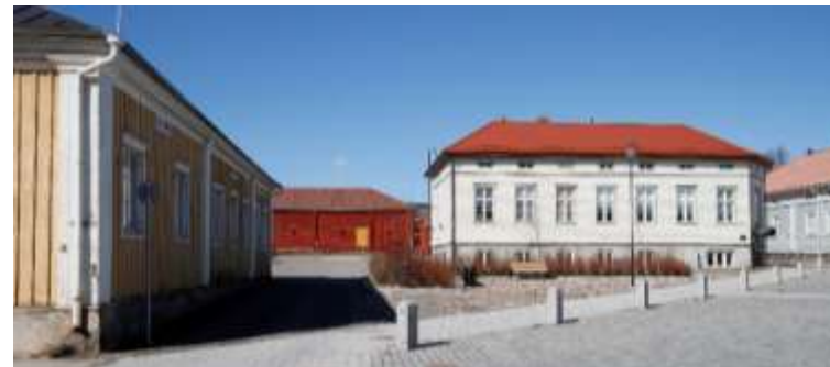
Kuva 109. Näkymä Peckatorin lounaiskulmaan. Vasemmalla on matala Hedmansonin talo ja oikealla alkujaan raatihuoneelle varatulle tontille rakennettu Reinin kauppakartano. Talojen välistä näkyy niiden itäpuolisella tontilla sijaitseva aitta.
