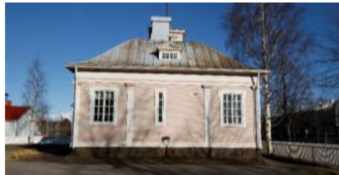
Kuva 163. Alun perin asunnoksi rakennettu rakennus Asemakadun varrella on yksikerroksinen ja aumakattoinen. Julkisivussa näkyy klassismin vaikutus etenkin julkisivua jäsentävissä pylväsaiheissa. Niiden kapiteelit ovat oikeaoppisesti yläpohjan palkistoa symboloivan vaakalistan alla.
