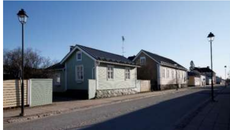
Kuva 155. Näkymä Koulukatua pitkin länteen. Katua reunustaa huolellisesti kunnostetut vanhat yksikerroksiset asuintalot, joiden välissä on aidat.
