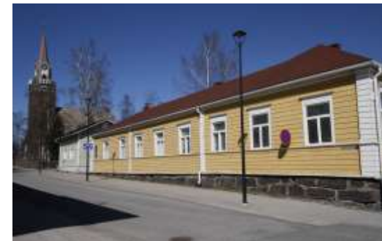
Kuva 87. Näkymä Pekkatorilta Kirkkokatua pitkin kohti kirkkoa. Kuvan oikeassa reunassa näkyy Pekkatoria reunustava Fontellin talo.
