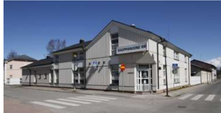
Kuva 102. Brahenkadun ja Reiponkadun risteyksessä sijaitsee puuverhoiltu 1980-luvun liikerakennus, joka mittakaavaltaan ja ulkoasultaan sopeutuu hyvin Reiponkadun muihin rakennuksiin.
