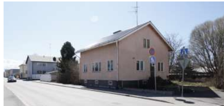
Kuva 103. Palokunnankadun varrella sijaitsee vaaleaksi rapattu jälleenrakennuskauden omakotitalo, jonka väljä tontti rikkoo katua rajaavien lamellikerrostalojen muurin.
