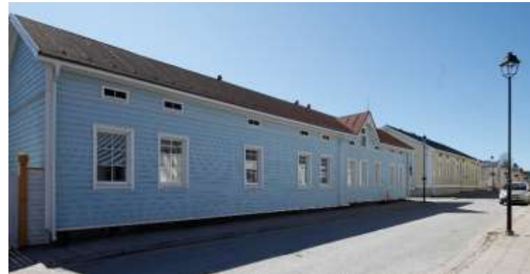
Kuva 137. Koulukatua reunustaa entisen Pelastusarmeijan talon länsipuolella yksikerroksiset 2000-luvun uudisrakennukset. Puuvuorattuina ne sopeutuvat hyvin kaupunkikuvaan.
