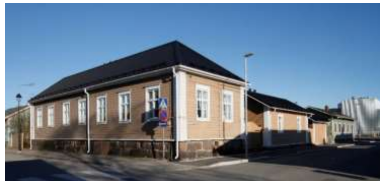
Kuva 156. Koulukadun ja Reiponkadun risteyksessä on aumakattoinen, yksikerroksinen vanha asuintalo, jonka nurkissa on raahelaiselle puuempirelle tyypilliset harkotetut nurkkapilasterit.
