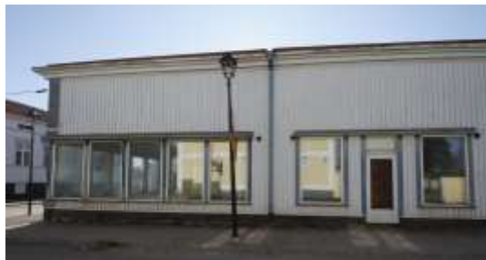
Kuva 73. Brahenkadun ja Kauppakadun kulmassa oleva aumakattoinen asuinrakennus on muutettu liikerakennukseksi. Pitkä nauhaikkuna on muuttanut huomattavasti rakennuksen ilmettä.
