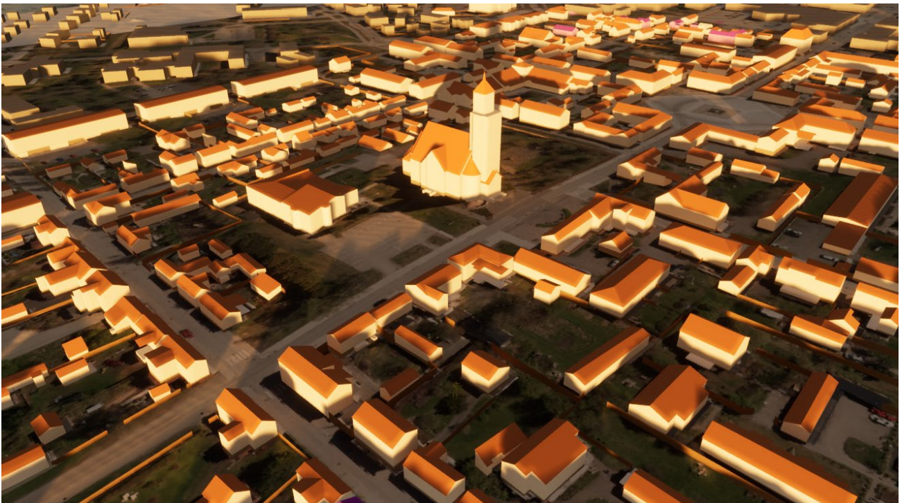
Kuva 3: 3d-mallinnus suunnittelualueelta. Kirkko muodostaa keskeisen kaupunkikuullisen kiintopisteen alueen keskelle. Vanhan kaupungin korttelirakenteessa näyttävimmät päärakennukset on perinteisesti sijoitettu kadun varteen ja talusrakennukset korttelialueiden sisälle.
