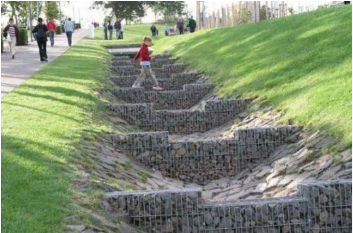
Porrastettu ja kivetty imeytyspainanne
